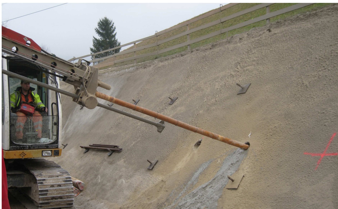
Abbildung 45: Einbringen des Bambusrohrs mit dem Bagger
