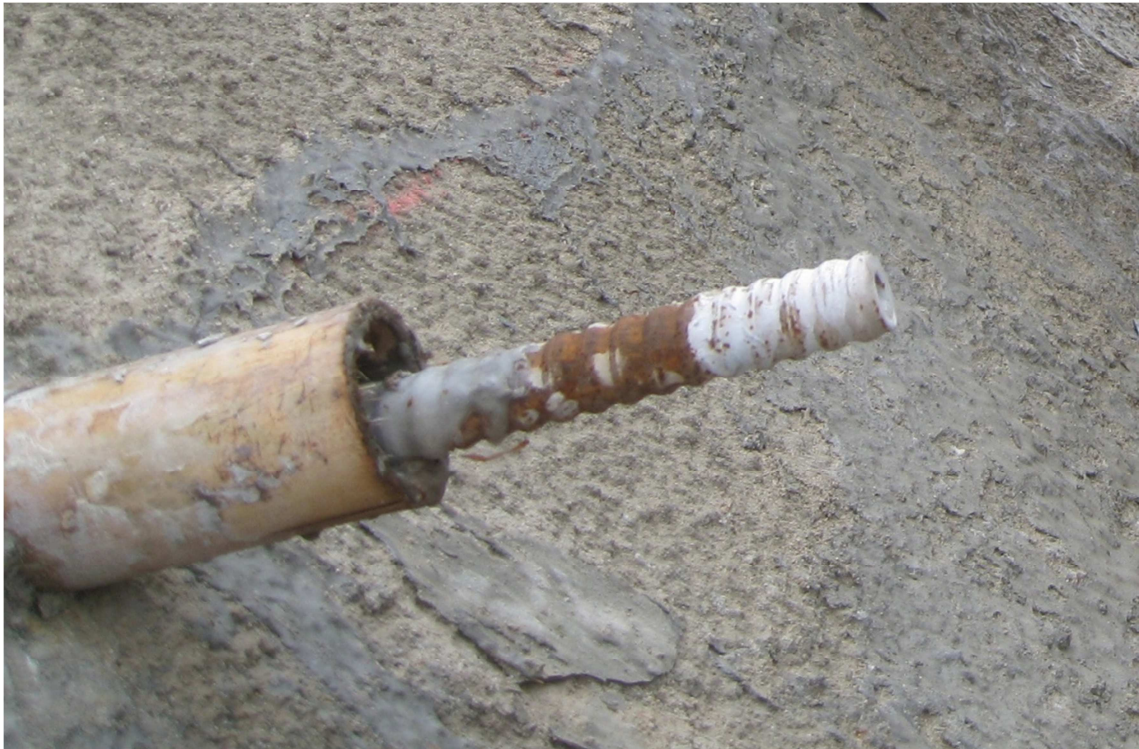
Abbildung 55: Stabstahl zum Ansetzen der Presse
