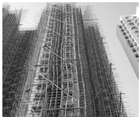
Abbildung 6: Baugerüst aus Bambus für ein Hochhaus [9]
