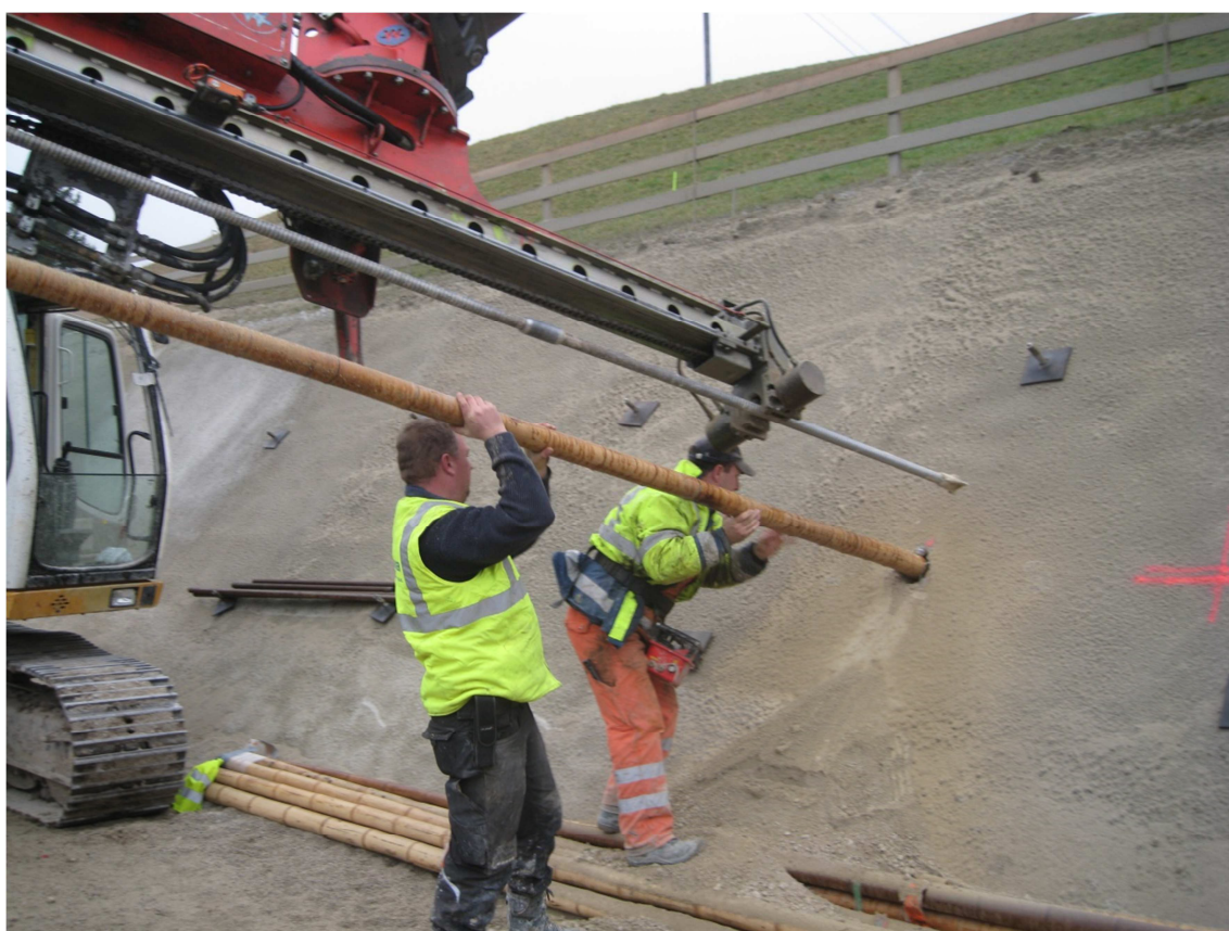
Abbildung 44: Händisches Einbringen des Bambusrohres
