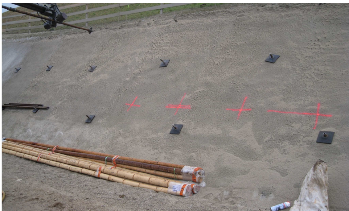
Abbildung 40: Positionen für die Bohrungen
