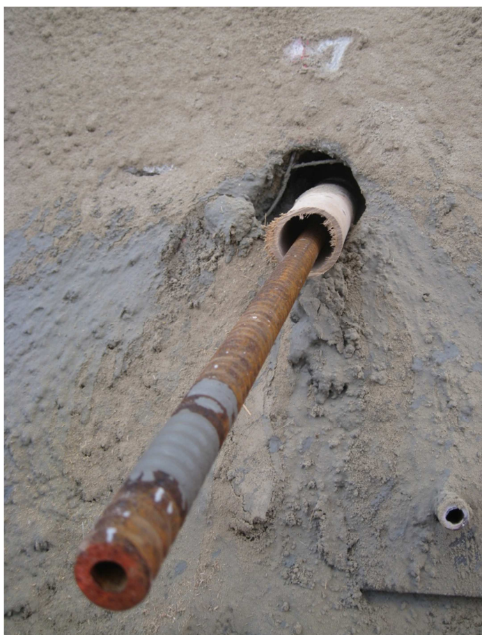
Abbildung 47: Kopfausbildung Bambusnagel
