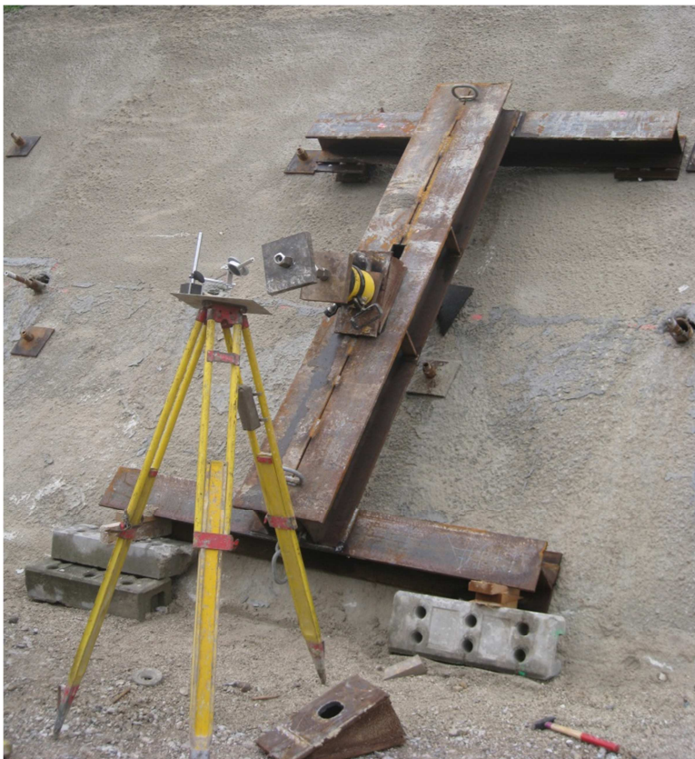
Abbildung 50: Traverse zur Nagelprüfung
