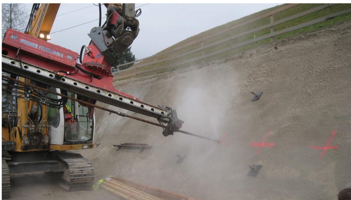
Abbildung 42: Spülung mit Druckluft
