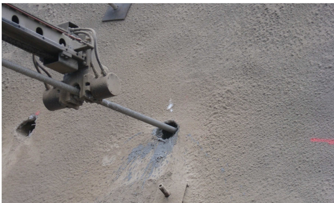
Abbildung 43: Einbringen der Suspension
