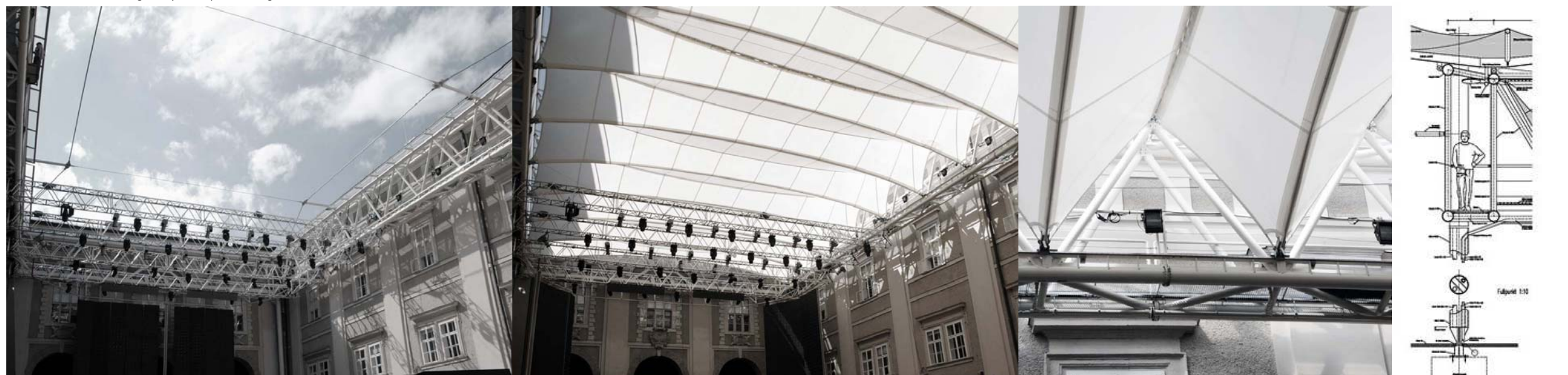
Abbildung 44: (links) Dach-offen Abbildung 45: (2.v.links) Dach-geschlossen Abbildung 46: (3.v.links) Auflagerpunkt - Linearsystem Abbildung 47: (rechts) Randträger
