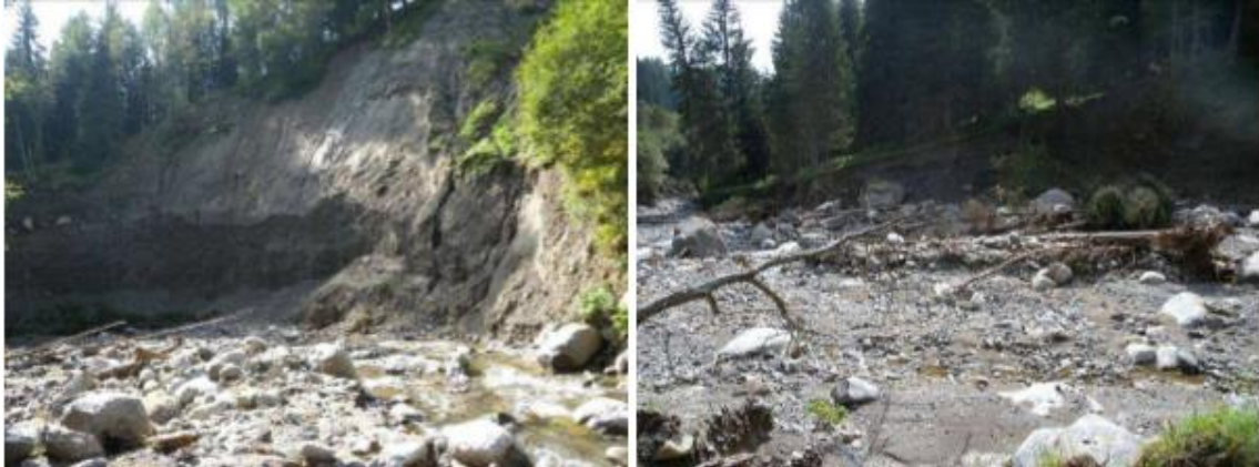
Abbildung 2: Schöttlbach –links Erosion des Hangfußes und rechts massive Gerinne- und Seitenerosion (Hübl, 2011)
