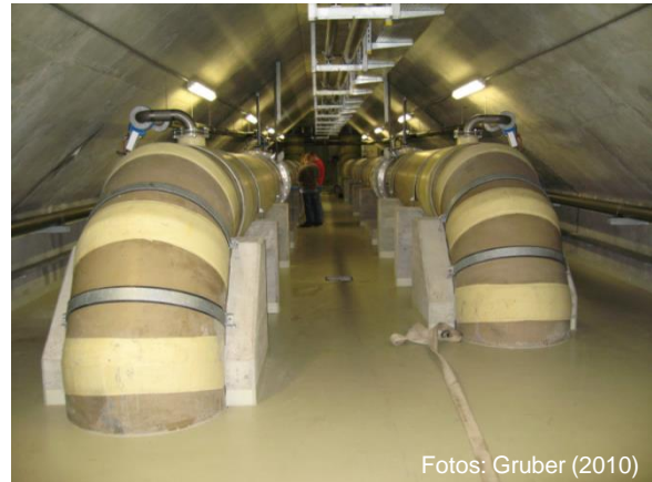
Abbildung 3-3: Lage der MIDs in den unterirdischen Dükerleitungen zwischen Sandfang und Vorklärbecken der ARA Graz (gegen die Fließrichtung aufgenommen)
