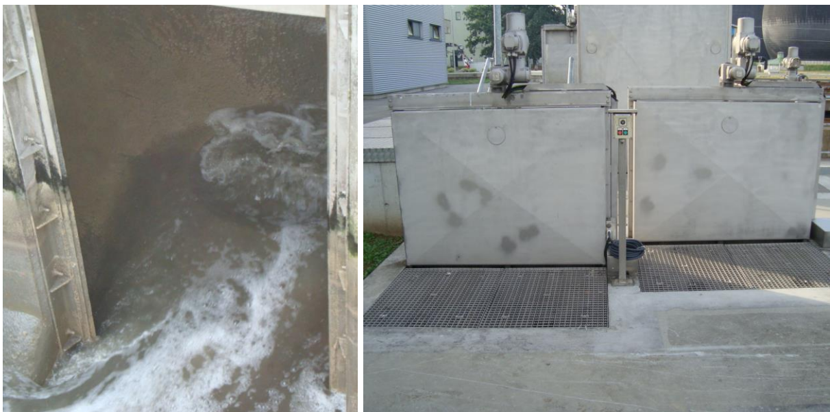
Abbildung 3-14: Ablauf Sandfang in den Zulauf zu einer der drei gedückerten Verbindungsleitungen zur Vorklärung (links); Zugangsgitter G2 und G3 mit Schiebern im Zulaufbereich des Verteilgerinnes zu den Vorklärung Becken der ARA Graz (rechts).
