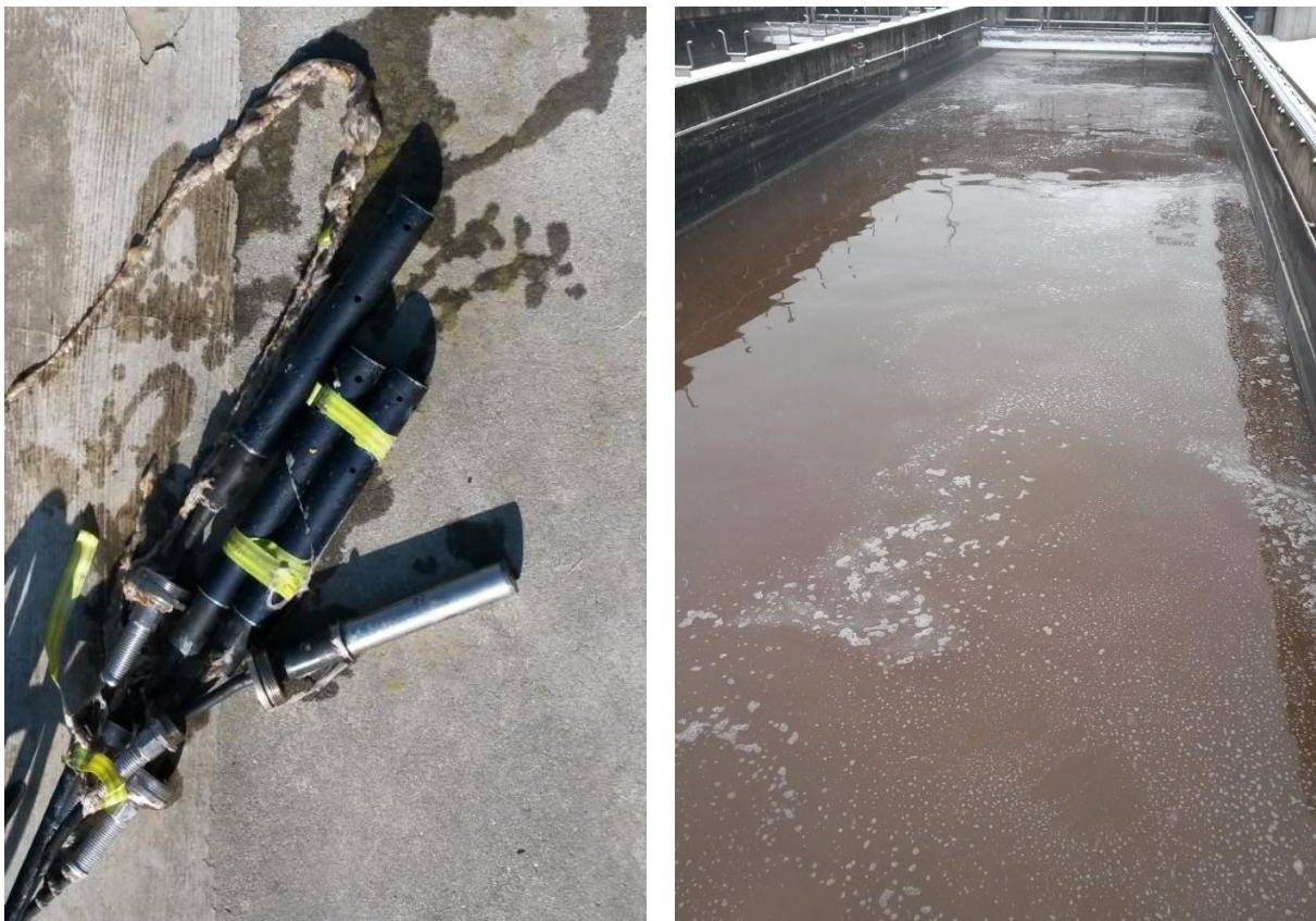
Abbildung 3-23: Online-Tracersonden nach 10 Tagen kontinuierlichem Messeinsatz im Zulaufbereich zur Vorklärung (links); rötlich gefärbtes Vorklärbecken inkl. Schaumbildung durch unbekanntem Stoff (rechts).
