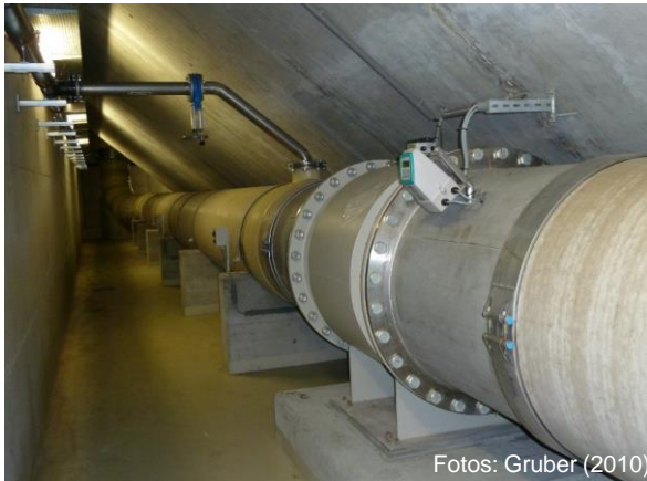
Abbildung 3-3: Lage der MIDs in den unterirdischen Dükerleitungen zwischen Sandfang und Vorklärbecken der ARA Graz (gegen die Fließrichtung aufgenommen)
