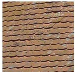
Biberschwanzdeckung am Wirtschaftsgebäude Nord
