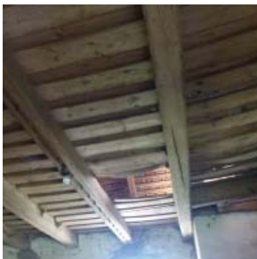
Holzbalkendecke im Wirtschaftsgebäude Süd
