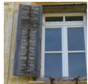
Kunststofffenster an der Südseite des Wohnhauses
