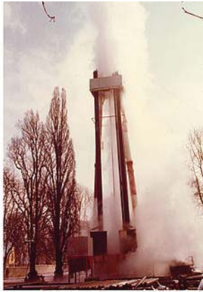
Erschließung der Thermalquelle 1978
