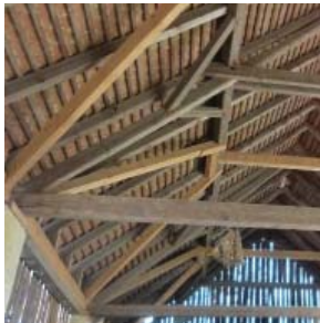
verstärkter Dachstuhl im Wirtschaftsgebäude Süd
