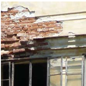
Freigelegte Vormauerung an der Mühlenfassade
