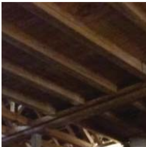
Holzbalkendecke im Mühlengebäude
