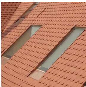
Bündiger Einbau von Dachfenstern
