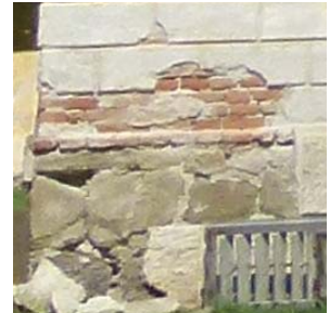
Sockeldetail des Wohnhauses
