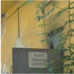
Gebäudeausschnitt vom Wirtschaftsgebäude Nord
