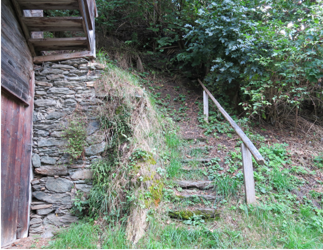
Abb. 22: Natursteinwand und anschließende Treppe, eigene Aufnahme, 2013
