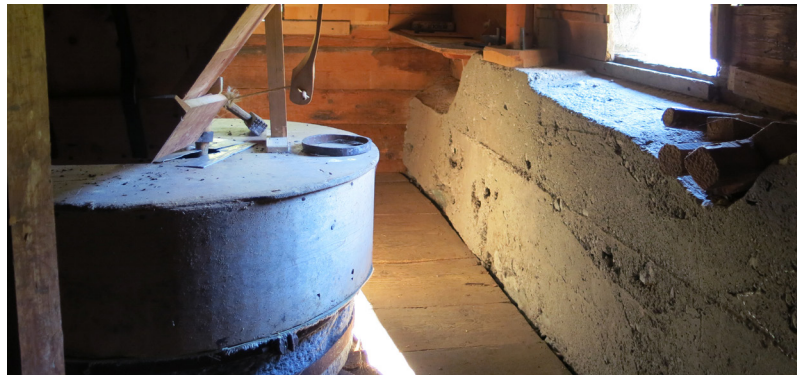
Abb. 21: Fundamentauer an der Westseite, eigene Aufnahme, 2013
