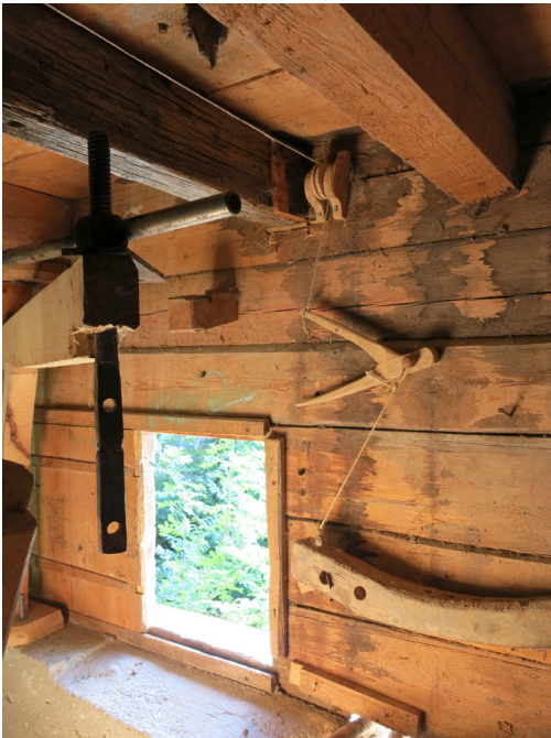
Abb. 58: Seilzug für die Wasserregelung, eigene Aufnahme, 2013
