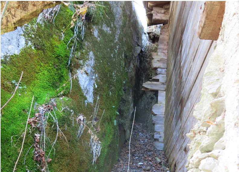
Abb. 19: Nordfassade, eigene Aufnahme, 2013
