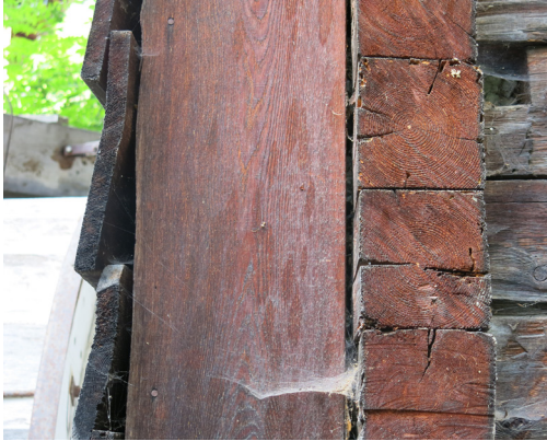
Abb. 32: (links) Bretterschalung Westfassade, eigene Aufnahme, 2013
