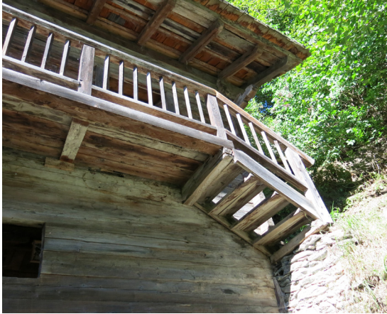
Abb. 45: Balkon Westseite, eigene Aufnahme, 2013
