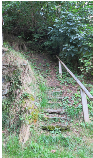
Abb. 50: Treppe im Außenbereich, eigene Aufnahme, 2013
