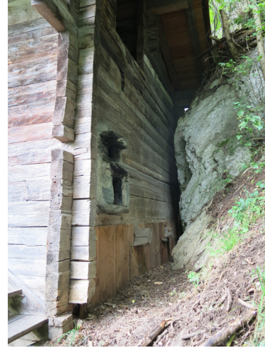
Abb. 23: Blick auf die Ostfassade und das Zwischenplateau, eigene Aufnahme, 2013
