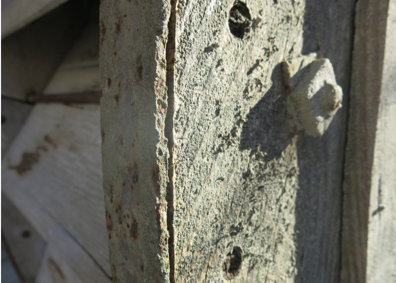
Abb. 71: Rostbildung am Wasserrad, eigene Aufnahme, 2013
