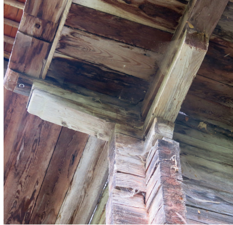
Abb. 46: Balkon Südseite, eigene Aufnahme, 2013
