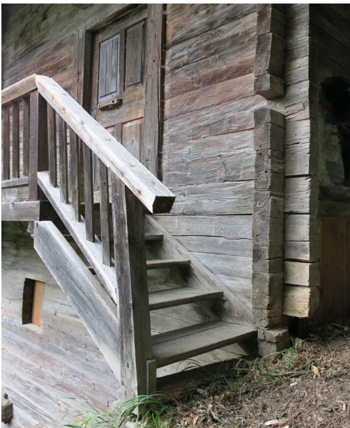
Abb. 24: Balkontreppe an der südöstlichen Gebäudeecke, eigene Aufnahme, 2013
