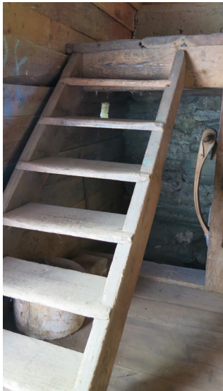
Abb. 49: Treppe im EG, eigene Aufnahme, 2013
