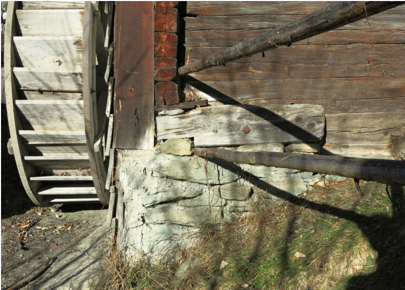
Abb. 65: Sockel und Blockwand- vorgesetzte Holzfassade, eigene Aufnahme, 2013
