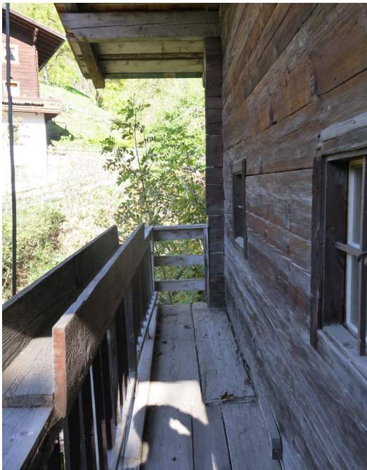
Abb. 47: Balkonkonstruktion, eigene Aufnahme, 2013
