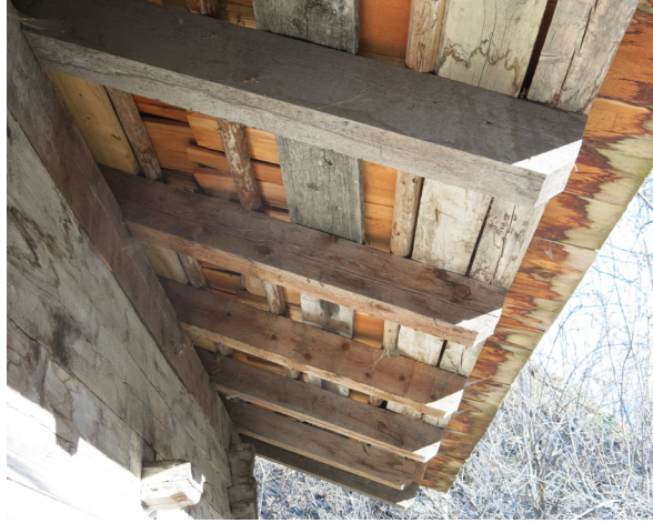
Abb. 36: (links) Dachdraufsicht, eigene Aufnahme, 2013
