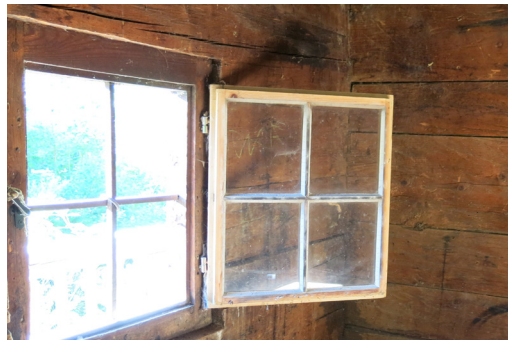
Abb. 41: Fenster OG - außen, eigene Aufnahme, 2013
