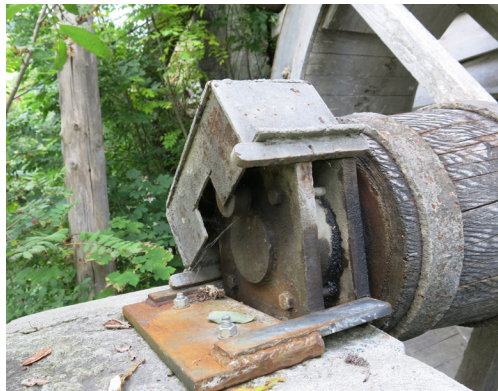
Abb. 55: Gleitlager, eigene Aufnahme, 2013
