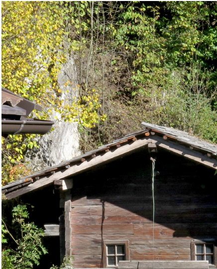
Abb. 14: Rücksprung des Dachs, eigene Aufnahme, 2013
