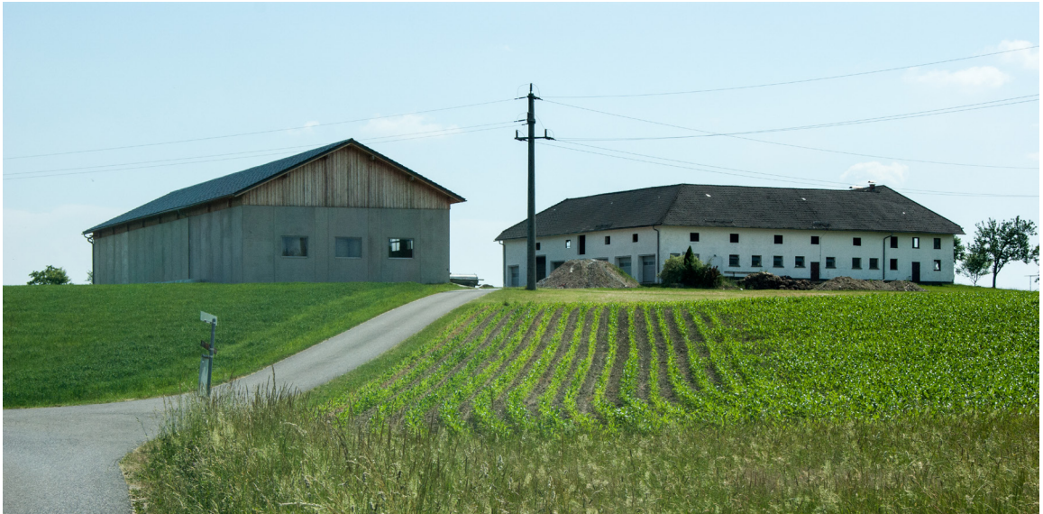
Abb.37: neue Wirtschafts- und Lagergebäude sprengen den ländlichen Maßstab
