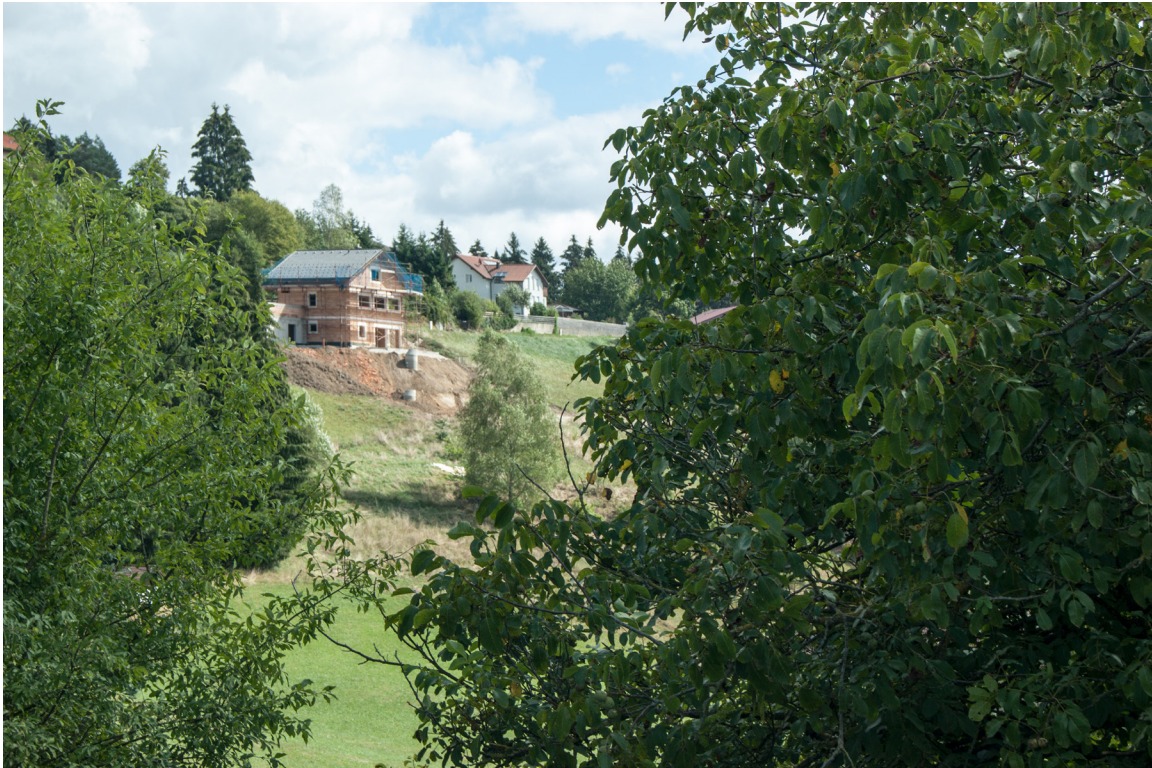
Abb.64: Neubau eines Einfamilienhauses und drei weitere zu verkaufende Bauparzellen auf den Nachbargrundstücken
