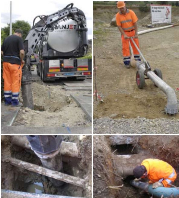
Abbildung 19 Einsatz Saugbagger 98
