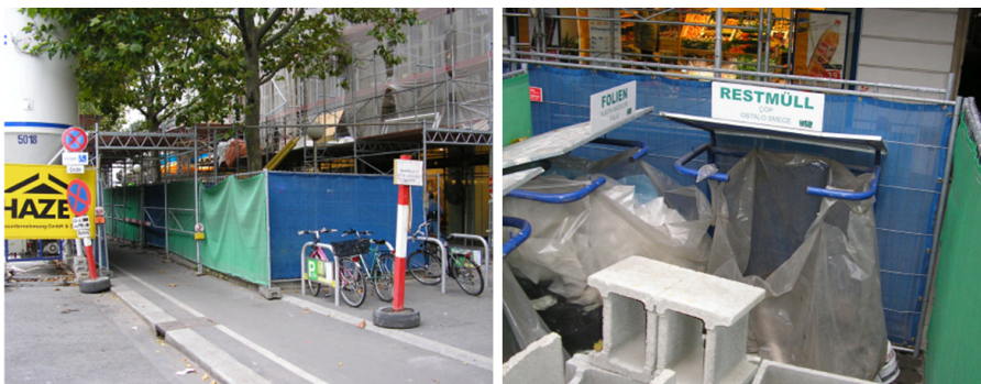
Abbildung 33 Baustellenabgrenzung mit Müllinsel
