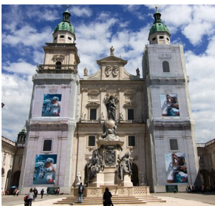
Abbildung 36 Restaurierung der Fassade des Salzburger Doms; auf den beiden Turmfassaden Werbung von H&M für Badeanzüge 125
