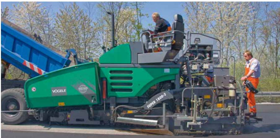
Abbildung 13 Aufsprühen Emulsion und Asphalteinbau in einem Arbeitsschritt
