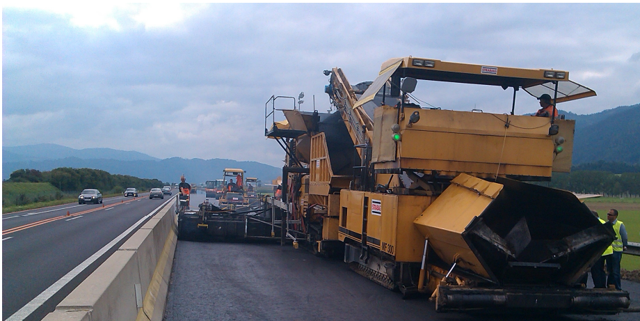
Abbildung 12 Beschicker mit Fertiger, der 2 Schichten einbaut
