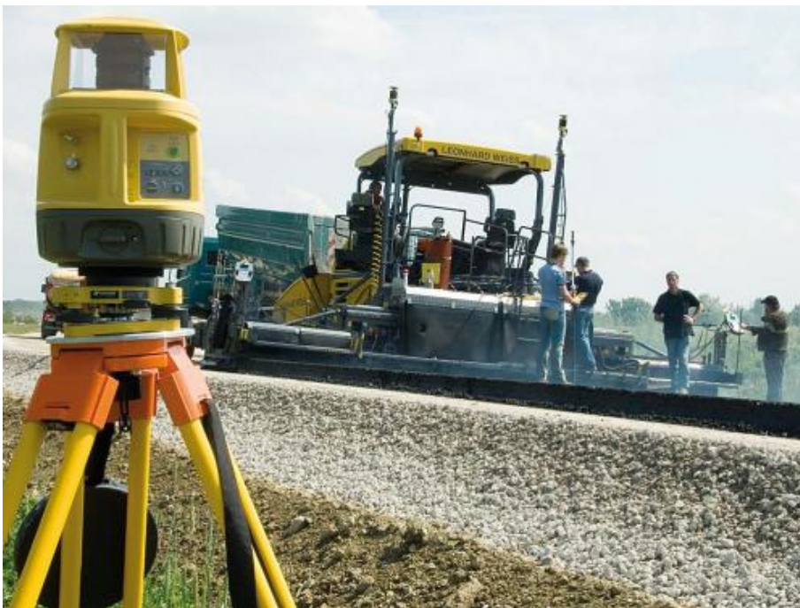
Abbildung 14 Ständiger Datenabgleich: Der Laser kommuniziert mit dem Laserempfänger am Fertiger 93
