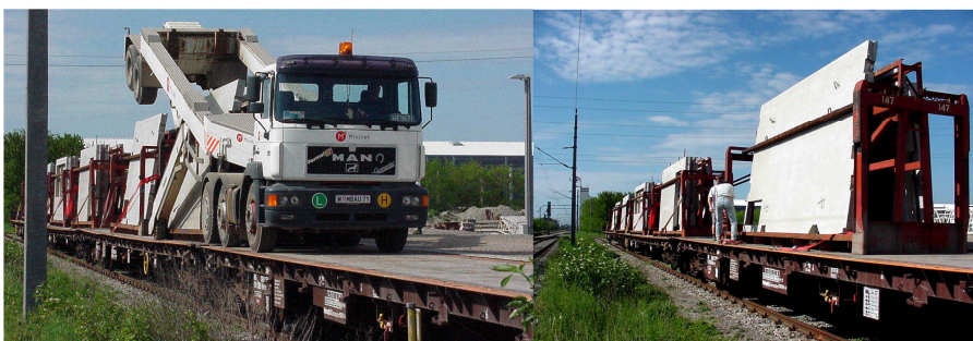
Abbildung 31 Fertigteiltransport per Bahn
