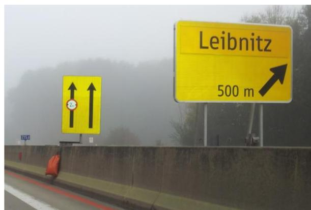
Abbildung 39: Momentan eingesetzte Befestigung für feste VZ auf Betonleitwand
