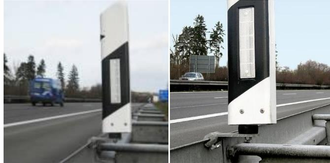
**Abbildung 36: Leitplankenbefestigung mit Stoßabsorber**
