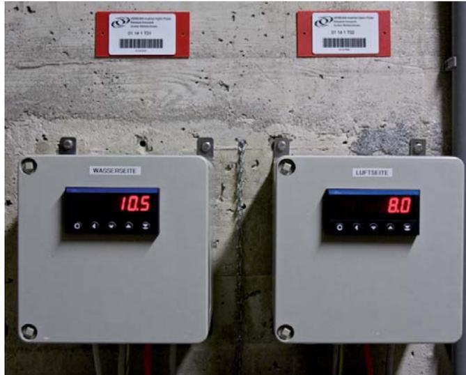
Abbildung 2.5: Signalverarbeitung der Messstellen T01 und T02
