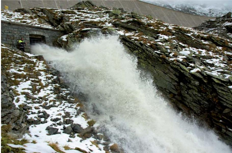
**Abbildung 2.4:** Sperre *Großer Mühlendorfer See* – Funktionsüberprüfung des Grundablasses
