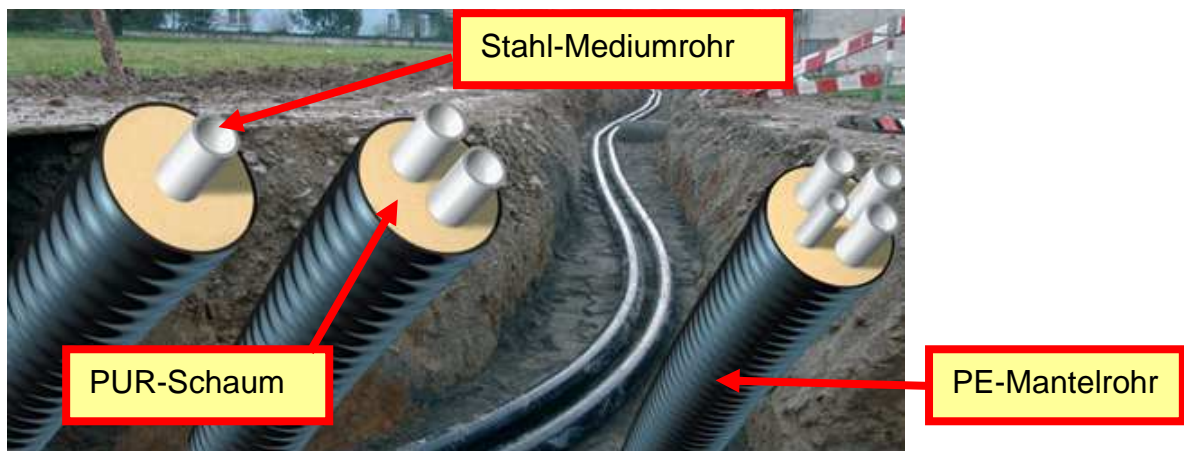
Abbildung 2.5: Querschnitte von verschiedenen Kunststoffverbundmantelrohren
