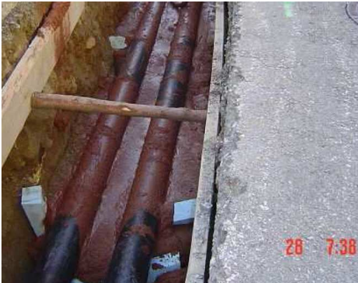
Abbildung 9.1: Verfüllung der fließfähigen, stabilisierten Thermosandmischung bis zur Rohrmitte
