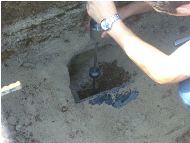
Abbildung 5.5: Verwendete Rammsonde Fischhofgasse
