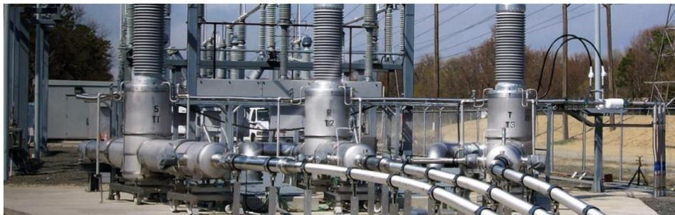
Abbildung 27: Einleiter HTS-Kabel Endverschlüsse auf Freileitung [NSC2]
