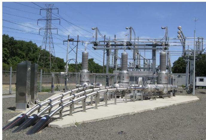
Abbildung 34: Endverschlüsse des 660 m langen LIPA1-Kabels [Quelle: AMSC]
