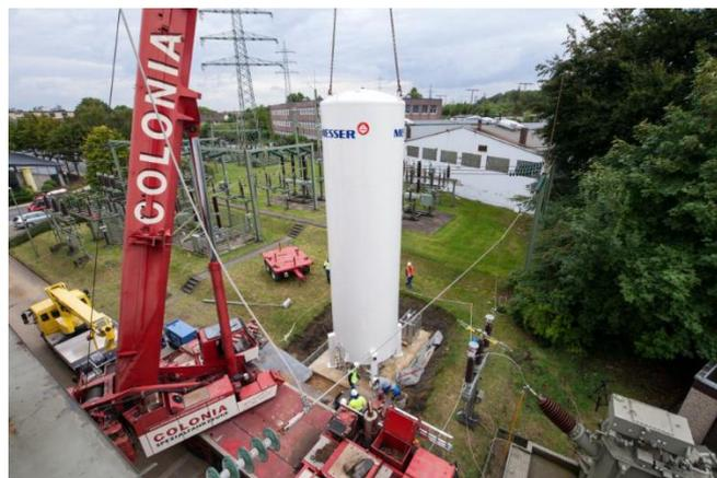
Abbildung 22: Stickstofftank für das AmpaCity-Projekt in Essen
