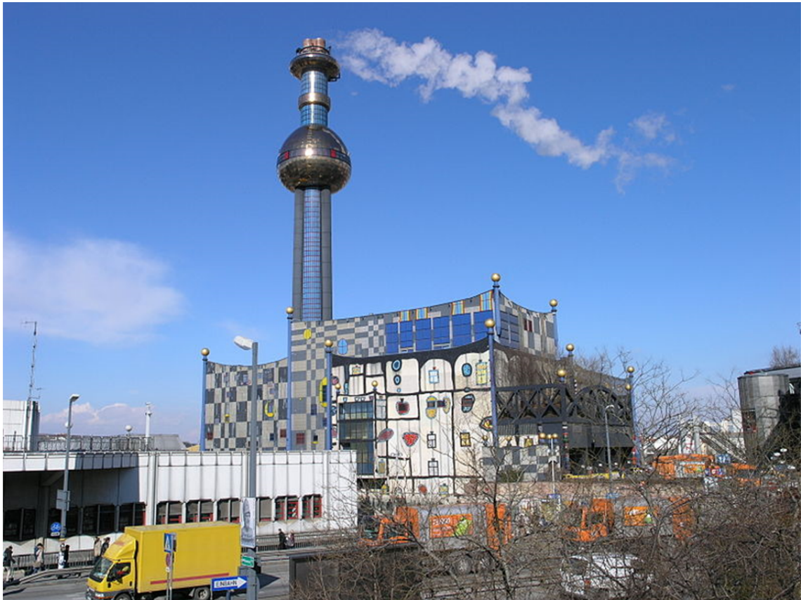
Abb. 1: Das Fernwärmeheizwerk Spittelau in Wien (de.wikipedia.org)
