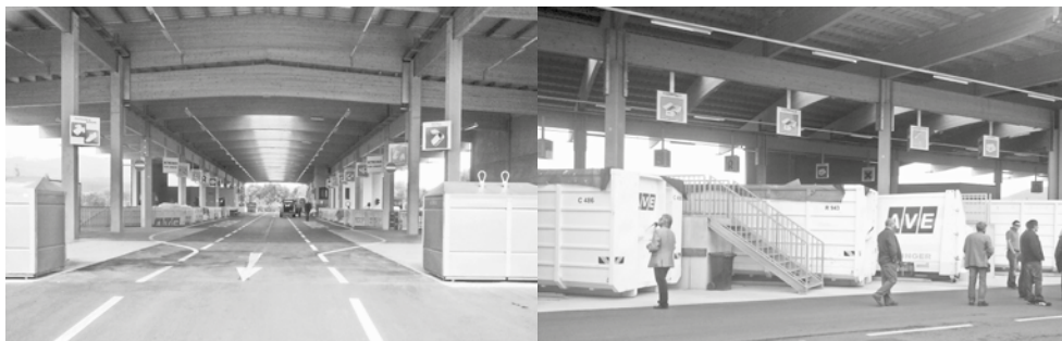
Dar. 7: Altstoffsammelzentrum Wals-Siezenheim von Baumeister Dellemann
