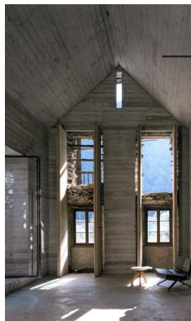
Nach dem Haus im Haus Prinzip wurde ein Betonkörper eingefügt, welcher im Gegensatz zu den natürlich belassenen Natursteinwänden steht. Durch das Muster der Bretterschalung wirkt der Beton lebhaft und die historische Atmosphäre wirkt verstärkt.
