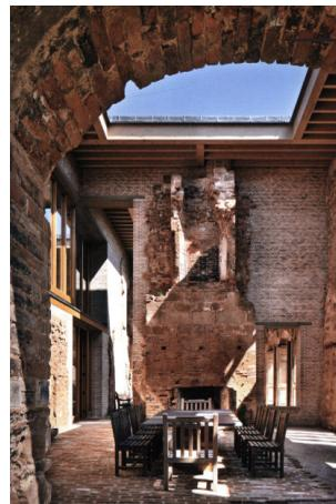
Die Ruine wurde teilweise belassen und die erforderlichen Räume in sie hineingebaut. Die Fehlstellen in der Fassade wurden mit Backstein, welcher heller als der Bestand ist, verfüllt. Das Fugenbild ist dabei kleinteilig und scheint sich den ruinösen Bauteilen unterzuordnen.
