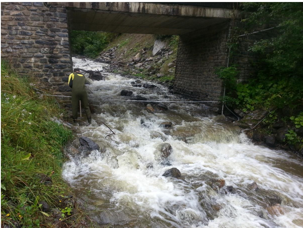
Abbildung 101: Abfluss bei der Brücke Krumeggerbach am 1. September 2014
