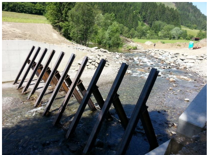
Abbildung 20: Baustelle: Unholzrechen bei Niederwölz
