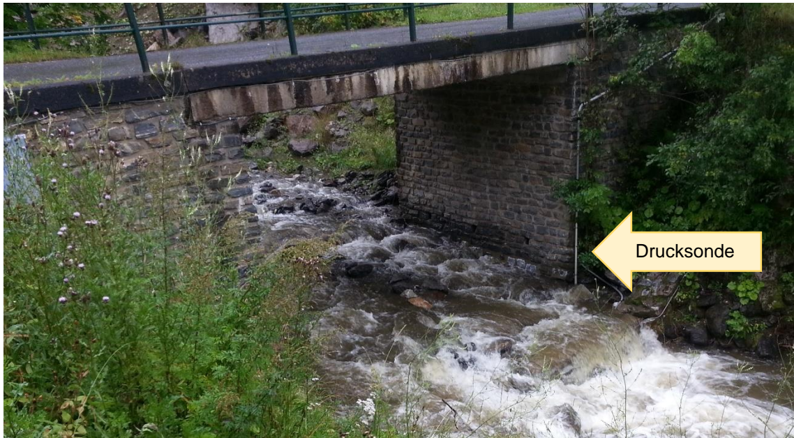
Abbildung 56: Druckpegelmessstation Brücke Krumeggerbach
