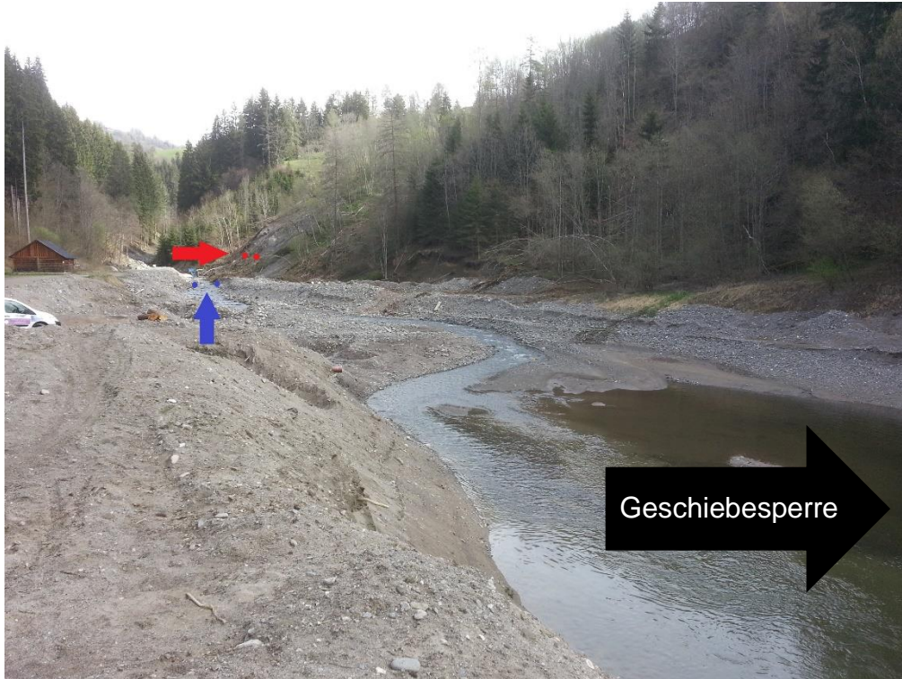
Geschieberückhaltebecken (Hohenbichlersperre) mit den Entnahmestellen im Hintergrund Die Geschiebesperre befindet sich im unteren rechten Eck
