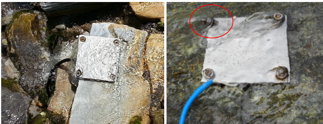
Abbildung 39 & 40: Sediment-Impact-Sensor auf beschädigtem Untergrund bzw. mit beschädigter Befestigungsschraube
