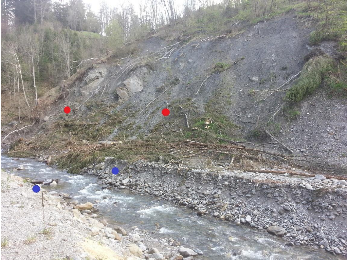
Entnahmestellen im oberen Bereich des Geschieberückhaltebeckens
