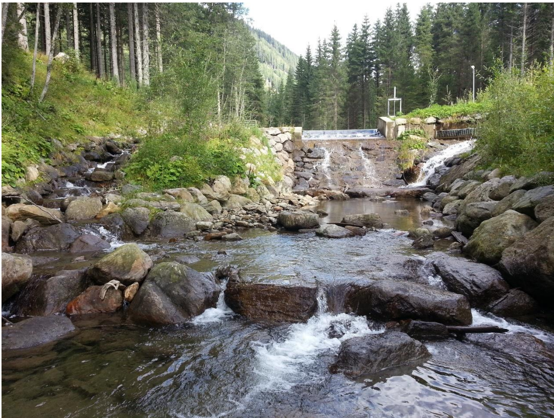
Im obigen Bild (Blickrichtung flussaufwärts) ist die Fischaufstiegshilfe (links im Bild) vom Ausleitungskraftwerk II am Schöttlbach dargestellt
