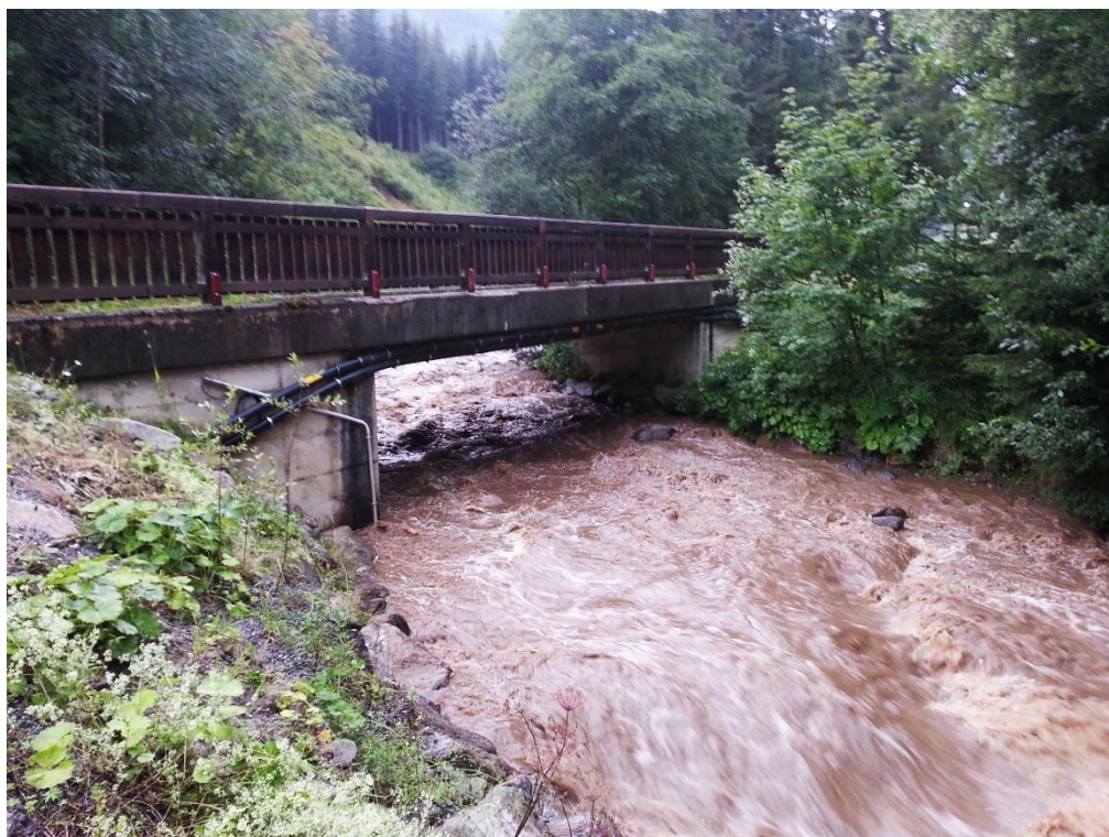
Abbildung 57: Brücke Schöttlikapelle (Blickrichtung flussaufwärts), Wasserstand bei einem Abfluss von ca. 3.5 \text{ m}^3/\text{s} , 2014
