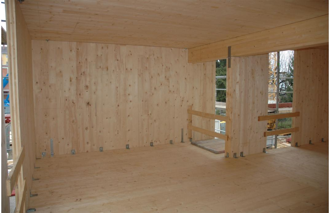
Abb. 1.5 Wand- und Deckenelemente aus BSP mit ergänzenden, linienförmigen Bauteilen aus BSH (Säule, Unterzug) im Wohnbau \_massive\_living
