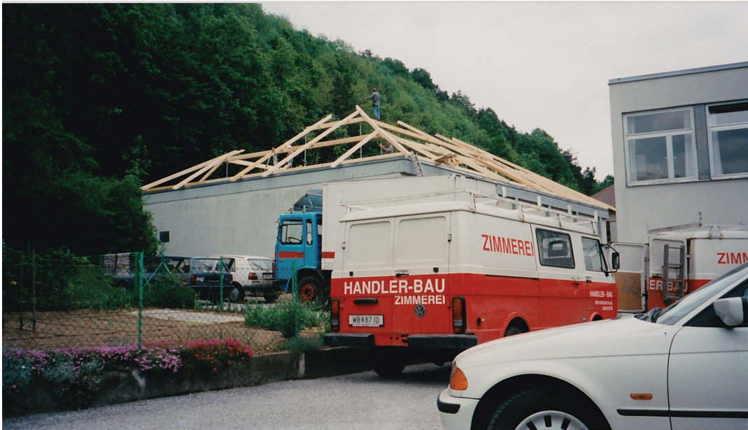
Beginn des Dachumbau, 1999
