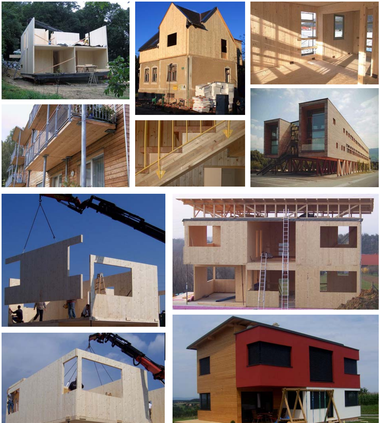
Abb. 1.3: Einsatzmöglichkeiten von BSP (vgl. [15])
