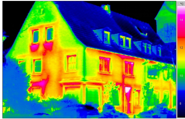
Abbildung 2.20: Thermogramm eines Gebäudes [63]
