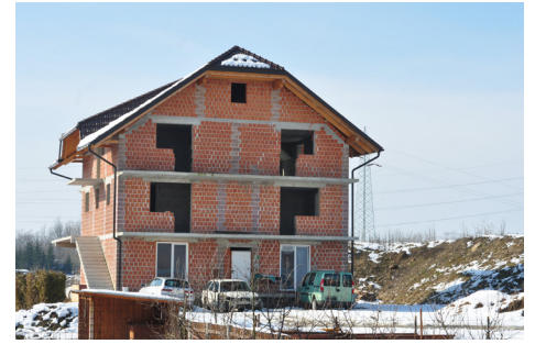
[6] Die Aussentreppe - ohne Funktion - Illegale Gebäude
