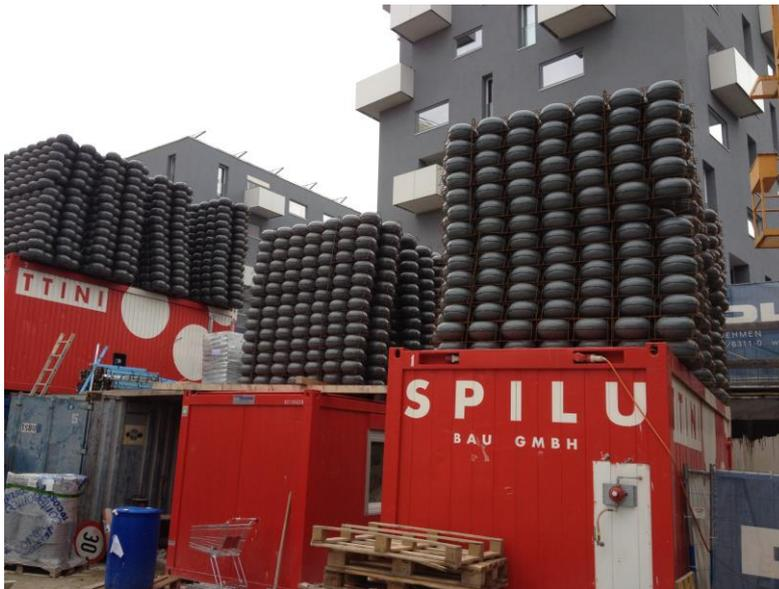
**Bild 12-4 : Lagerung der Kunststoffhohlkörper für die Leichtbetondecken**
