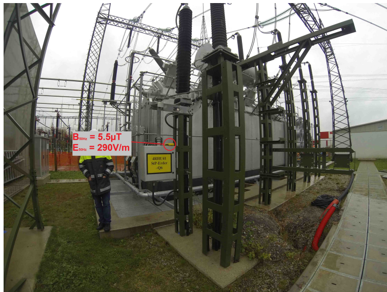
Abbildung 3.6.: Veranschaulichung des Messorts für spätere Feldmessungen am Transformatorsternpunkt. Die Magnetfeldmessung wurde an einem 300MVA Transformator im Süden Österreichs durchgeführt.
