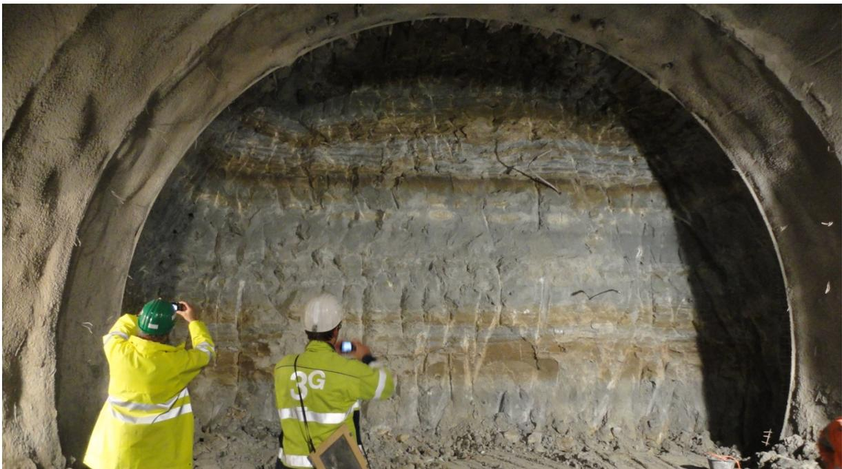
**Abbildung 3-37: Ortsbrust nach der Sprengung (Tunnelabschnitt Nord-Ost, Neogen)**
