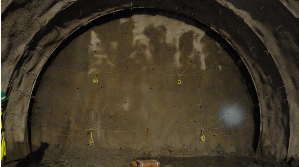
**Abbildung 3-36: Geladener Sprengstoff in der Kalotte (Tunnelabschnitt Nord-Ost, Neogen)**
