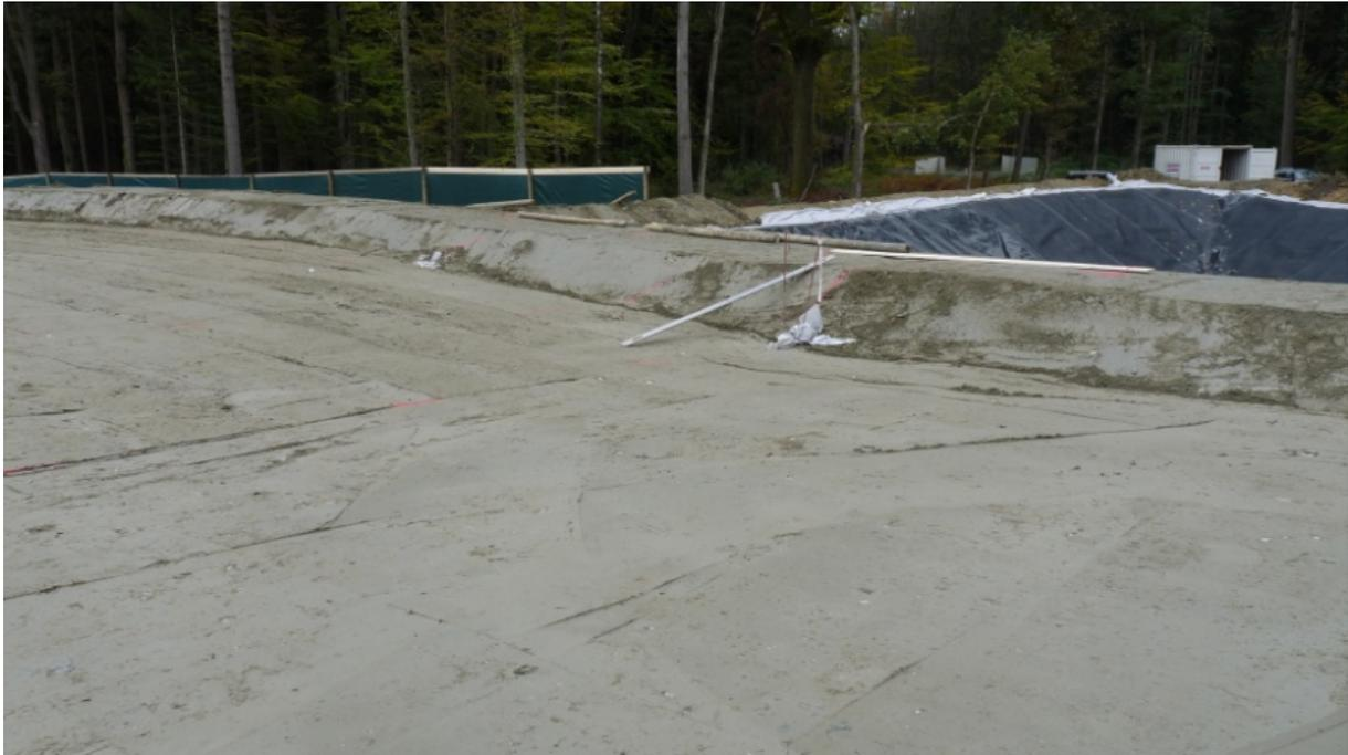
**Abbildung 3-10: Dichtschicht aus neogenem Material - Deponie H2**
