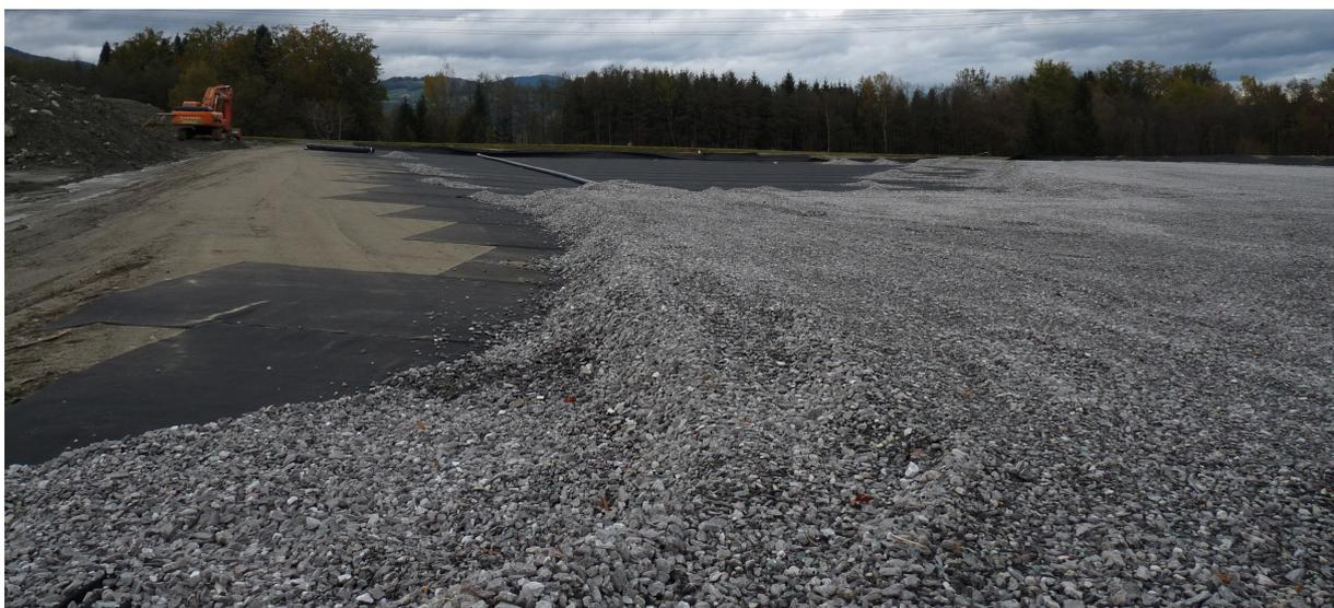
**Abbildung 3-11: Filterschicht aus kristallinem Material - Deponie H2**
