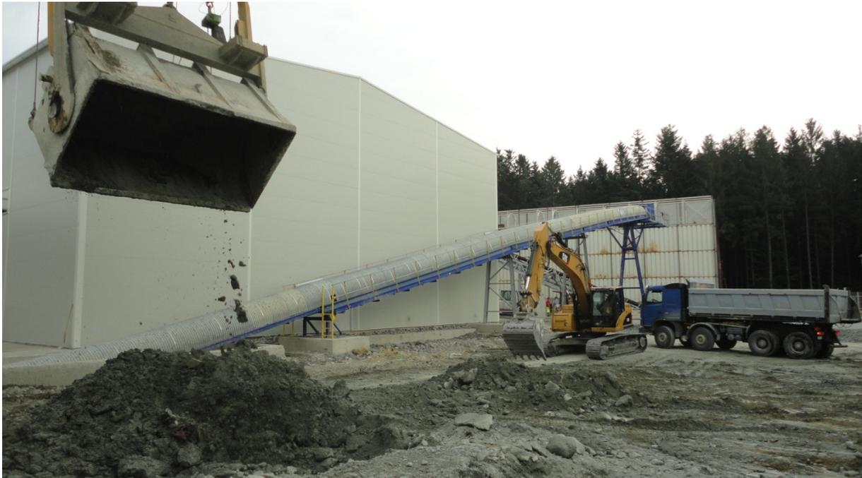
Abbildung 3-38: Aussortierung von Spritzbetonresten im Ausbruchmaterial
