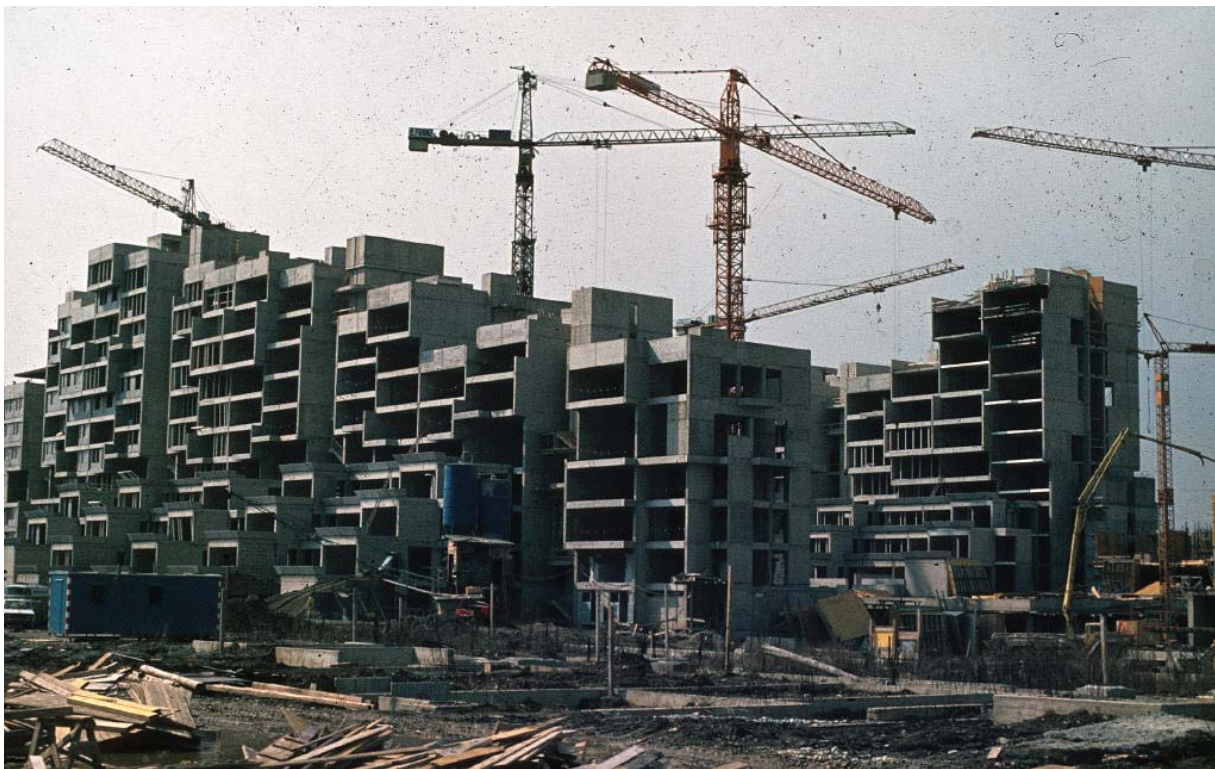
Abb.36 Foto, Baustellenfoto Terrassenhaussiedlung
