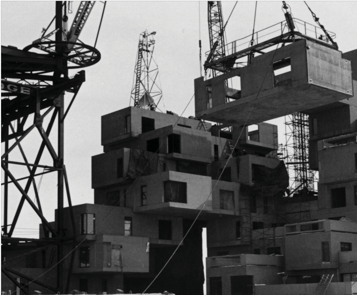
Abb.47 Foto , Baustellenfoto Wohnexperiment Habitat
