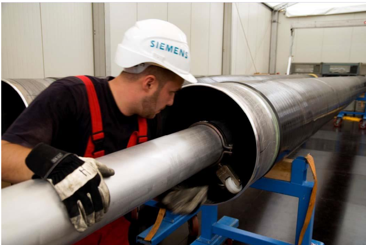
Abbildung 15: Fertigstellung der GIL-Module auf der Baustelle [20]
