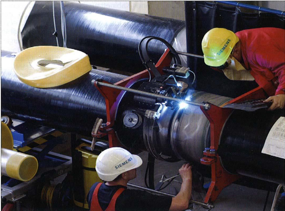
Abbildung 16: Verbindung der Kapselungen mittels Orbitalschweißgerät [20]
