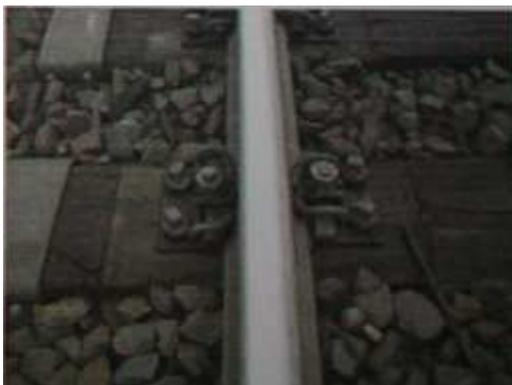
Abbildung 9: Rippenplatte mit Spannklemme [7]
