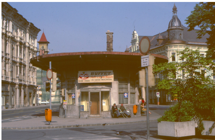
Abb. 32: Hans Gasser Platz 1984, drei Jahre vor dem Abriss. 33
