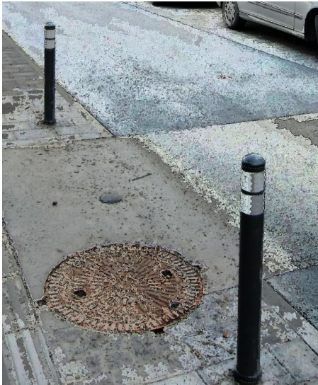
Abb. 28: Poller nach der Umgestaltung 135
