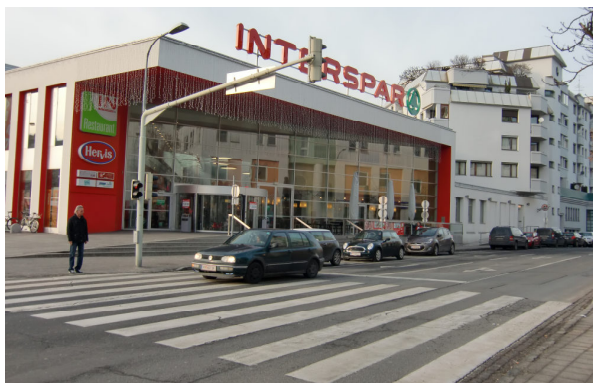
Abb. 12: Blick nach Nordwesten auf das EKZ 61
