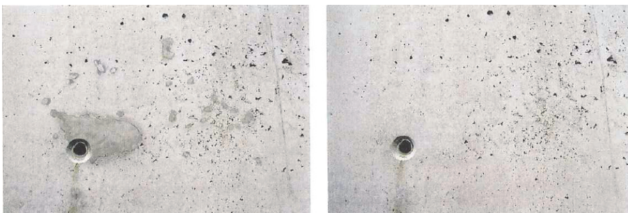
Abbildung 4.5 Nachbearbeitung einer Ankerstelle 65
