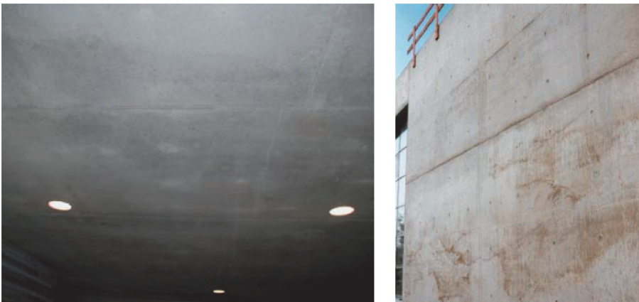
Abbildung 4.3 Anwendung von Schleiftechniken an Sichtbetonflächen 53
