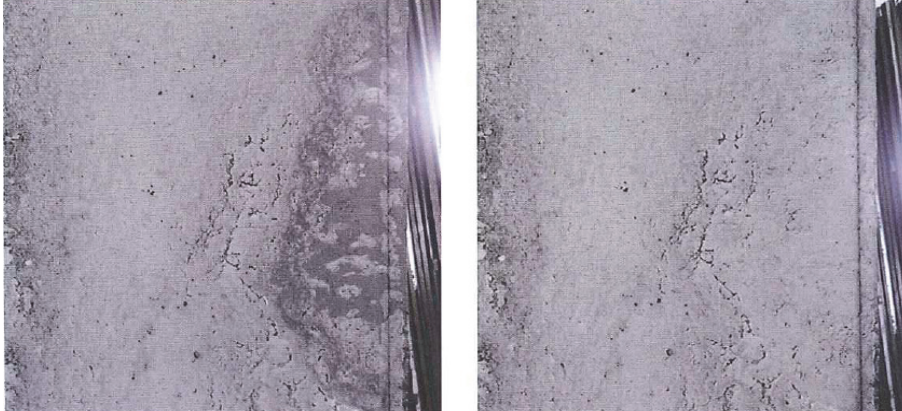
Abbildung 4.4 Restaurierung einer ausgebluteten Betonkante 64
