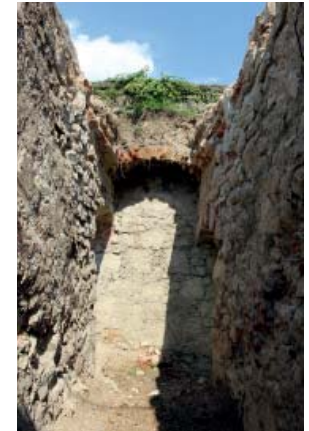
386 OSTWAND RAUM 2 - K F .2.2, ZIEGELRESTE TONNENGEWÖLBE
