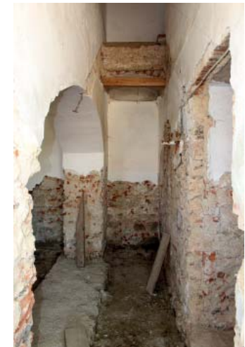
194 SÜDWAND 0.7.3, ABZEICHNUNG TREPPE, OBEN ZW.PODEST
