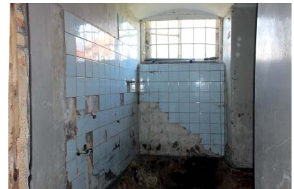
174 WÄNDE 0.4b.4 UND 0.4b.1 MIT FENSTER 0.4b.1.1
