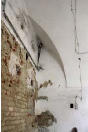
205 'ABGESCHNITTENE' STICKKAPPE (0.8.D) DURCH OSTWAND 0.8.2
