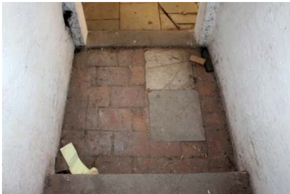
290 ABSATZ VOR TREPPE 1.3a.B
