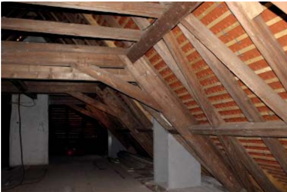
377 JEDER 4. SPARREN VERSTÄRKT, OSTFLÜGEL (BLICK VON S NACH N)
