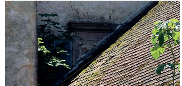
413 ZUGEMAUERTE ÖFFNUNG IN NORDWAND KLOSTER
