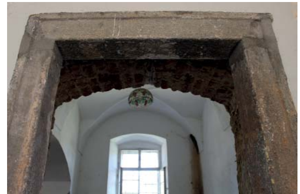
180 BLICK VON GANGÖFFNUNG (0.5.3.1) IN RAUM ZU NORDWAND
