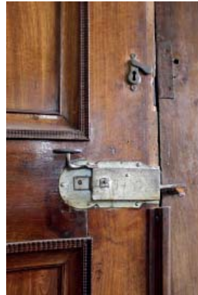
275 DETAIL KASTENSCHLOSS 1.1.4.1
