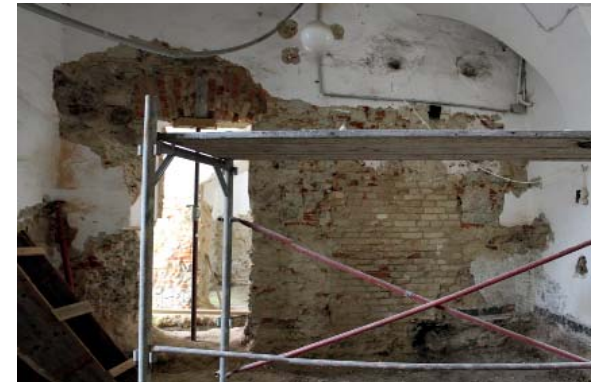
203 OSTWAND 0.8.2, ÖFFNUNG 0.8.2.1, ANDERE WANDSTRUKTUR
