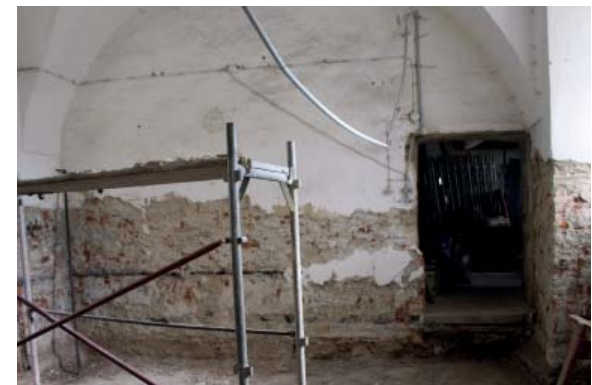
204 WESTWAND 0.8.4, ÖFFNUNG ZU REMISE 0.8.4.1
