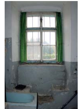
263 OSTEN, FENSTER 0.18.2.1, EHEMALIGER EINGANG
