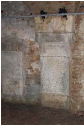
397 EINGEMAUERTE DRITTE GRANITSÄULE IN SÜDLICHER TW, LINKS DAVON VERSCHLOSSENE ÖFFNUNG ZU GASTHAUSKELLER
