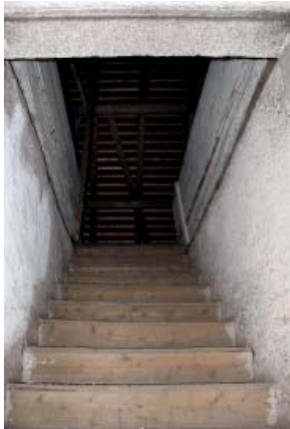
294 OBERER TREPPENLAUF, SICHT AUF DACHKONSTRUKTION
