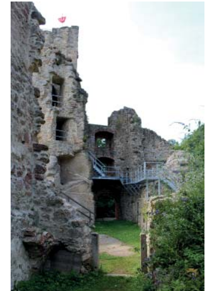
51 INNENANSICHT RUINE, BEGEHBAR DURCH METALLSTEGE
