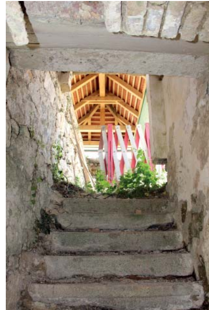
391 TREPPENAUFANG ÜBER SÜDLICHES TREPPENHÄUSCHEN
