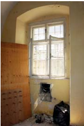
232 WESTWAND MIT FENSTER UND AUSSENWAND-KONVEKTOR
