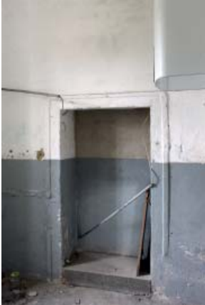
264 SÜDWAND, VERMAUERTE ÖFFNUNG 0.18.3.1
