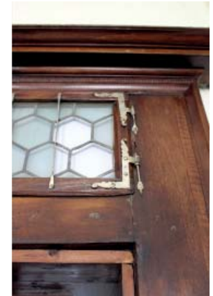
276 DETAIL BESCHLÄGE OBERLICHT
