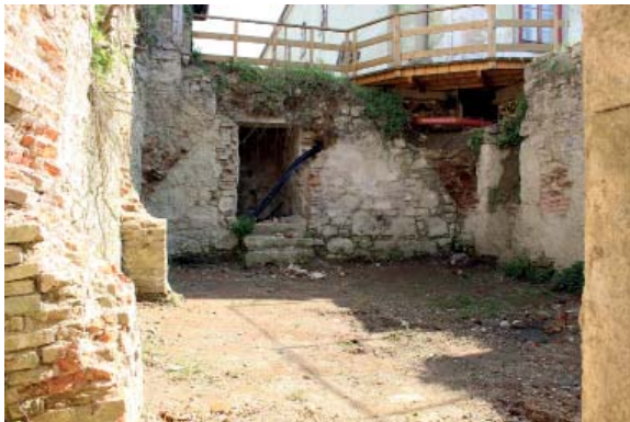
389 SÜDWAND RAUM 3 - Kf.3.3, AUFANG ZU EG, HOLZPODEST
