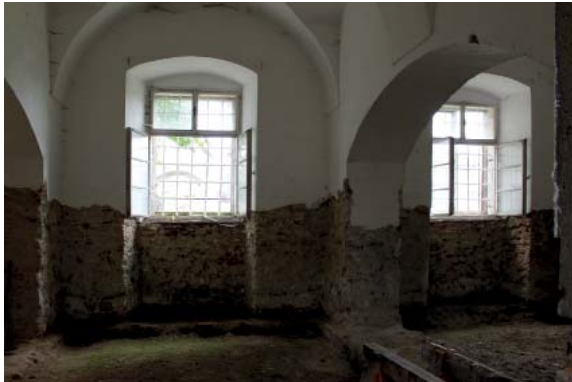
187 NORDWAND 0.6.1, RECHTS DURCHBRUCH UND WAND 0.5.1
