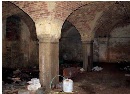
398 GEWÖLBEKELLER, BLICK NACH SÜDOSTEN
