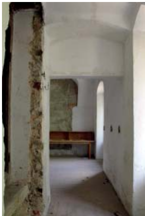
311 WESTWAND MIT DURCHGANG ZU RAUM 1.7
