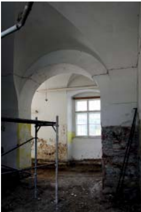
206 SÜDWAND MIT RUNDER ÖFFNUNG ZU GANG 0.8.3.1
