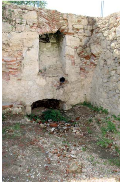
390 WESTWAND RAUM 3 - Kf.3.4, MÖGL. WEITERER ABGANG
