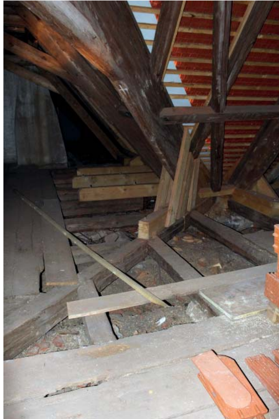
381 DACHKEHLE VON INNEN MIT AUSGEBESSERTEN HOLZBALKEN
