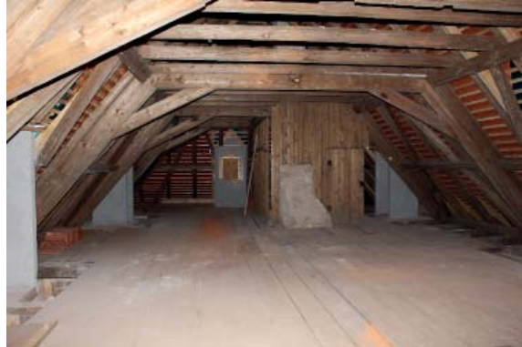
375 BLICK AUF SÜDABSCHLUSS DACH - WALMFÖRMIG
