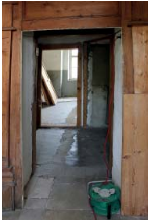
296 BLICK DURCH TÜRRAHMUNG IN DIE RÄUME 1.4a/b
