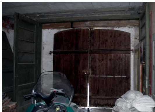
406 TOR NORDSEITE R-EG.1.1
