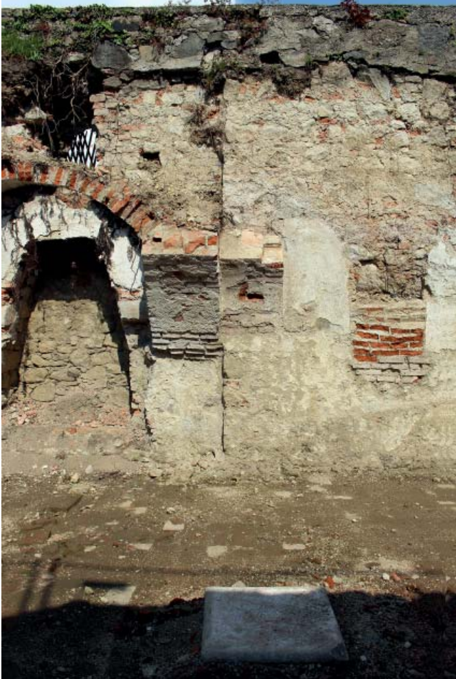
392 ZÄSUR OSTWAND RAUM 1 - Kf.1.2, KEINE VERZÄHNUNG IM MAUERWERK
