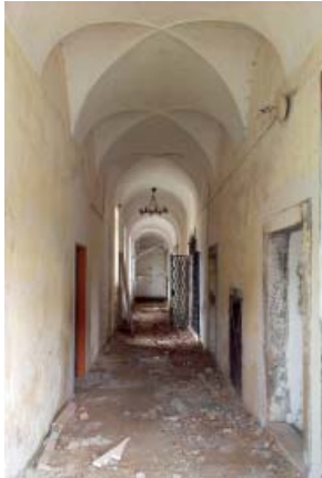
210 GANG - BLICK RICHTUNG WESTWAND
