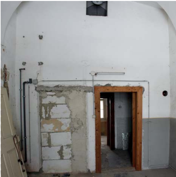
301 TW SÜDEN 1.4b.3 MIT VERMAUERTER TÜR
