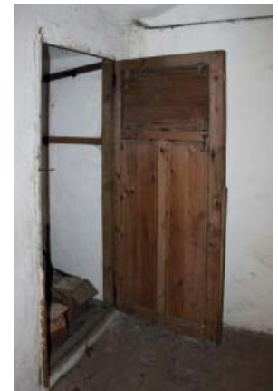
292 ZWISCHENPODEST, ABSTELLRAUM 1.3b.1.3
