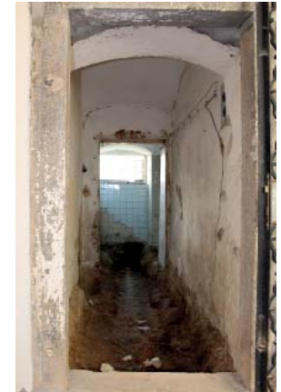
173 ÖFFNUNG 0.4a.3.1, BLICK IN VR UND WEITER IN RAUM 0.4b
