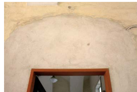
217 VERMAUERTER WANDBEREICH ÜBER TÜR 0.9.3.1
