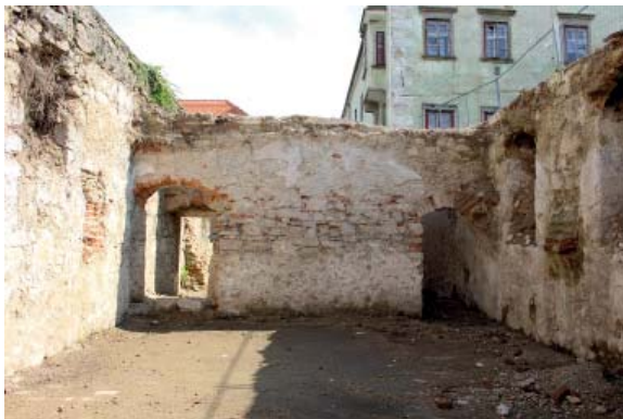
385 SÜDWAND RAUM 1 - K F .1.3, ZWEI ÖFFNUNGEN, PUTZRUNDUNG
