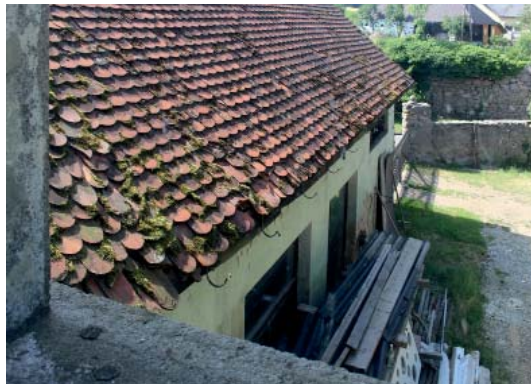
321 BLICK VON FENSTER AUF DACH REMISE
