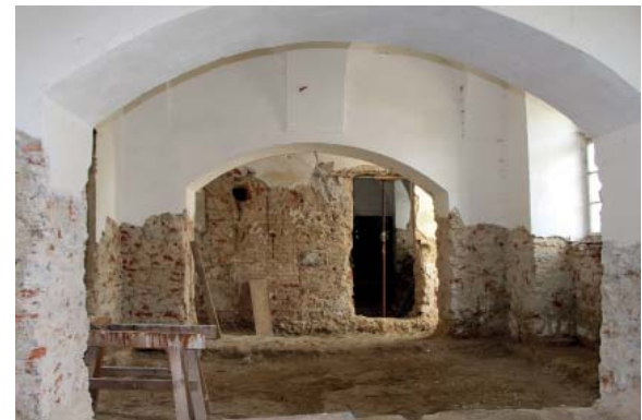
185 WANDDURCHBRUCH 0.5.4.1, BLICK IN RÄUME 0.6 + 0.7
