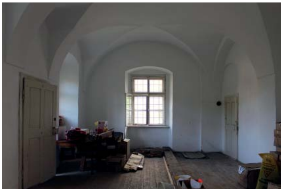
251 SÜDSEITE RAUM 0.16.3, LINKS EINGANG
