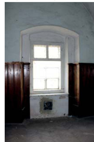
284 BAROCKFENSTER 1.2.1.1, VERTÄFELUNG, AW-KONVEKTOR
