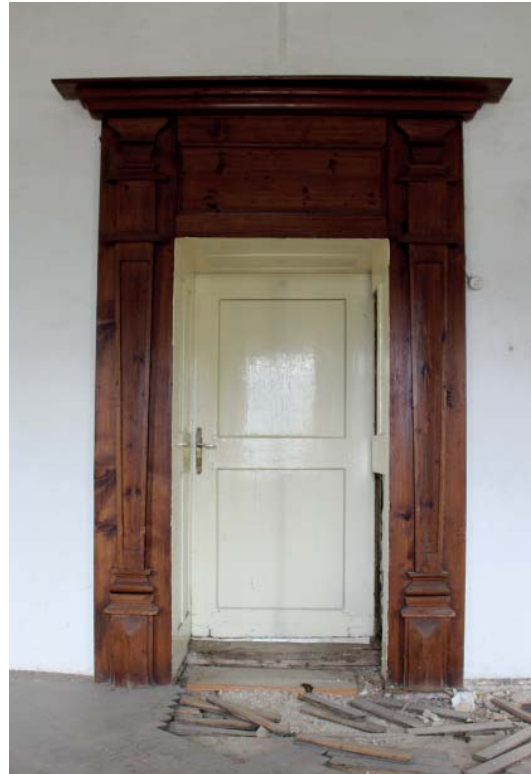
282 TÜRRAHMUNG OBERGESCHOSS, LAIBUNG/TÜR ERNEUERT
