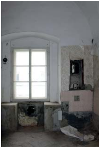
344 WESTWAND, FENSTER 1.13.4.1 UND ÖFFNUNG 1.13.4.2
