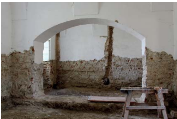
188 OSTWAND 0.6.2 MIT DURCHBRUCH ZU RAUM 0.5
