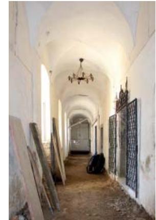
212 LINKS HOF-FENSTER, RECHTS AUFGANG HAUPTTREPPE
