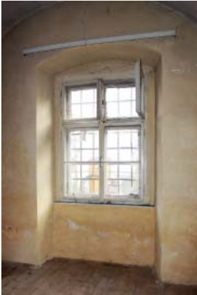
247 FENSTER (KURZSEITIG) SÜDWAND 0.15.3.1
