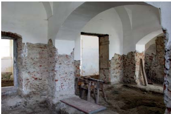
183 WANDECKE SÜD-WEST 0.5.3/4, DURCHBRUCH ZU RAUM 0.6
