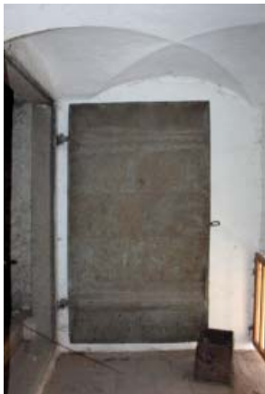
293 ZWISCHENPODEST, TÜRE ZU DG 1.3b.3.2
