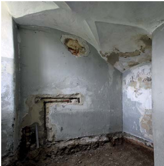
176 OSTWAND 0.4b.2 UND RECHTS SÜDWAND 0.4b.3
