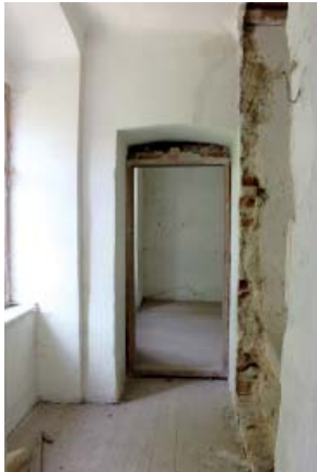
310 OSTWAND 1.6.2, RECHTS AUSRISS VON EHEM. TW SICHTBAR
