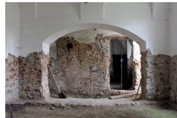
192 WESTWAND 0.6.4, BLICK AUF WAND 0.7.4
