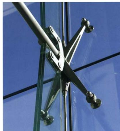
**Abb. 3.9** Links: Lochleibungsverbindung schematisch[17]; Rechts: Lochleibungsverbindung - Sony Center Berlin [31]
