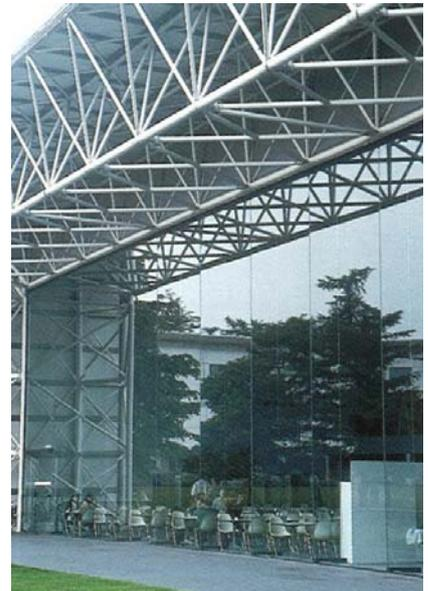
**Abb. 5.8** Links: Isometrie des Systems; Rechts: Fassade mit Dreigurtfachwerkträger und Glasschwerter [7]
