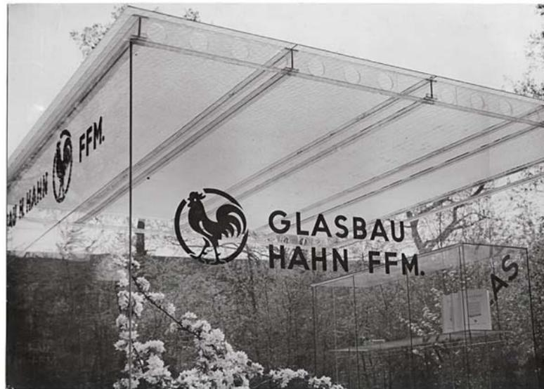
**Abb. 2.3** Ganzglas-Ausstellungspavillon der Firma Glasbau Hahn [41]
