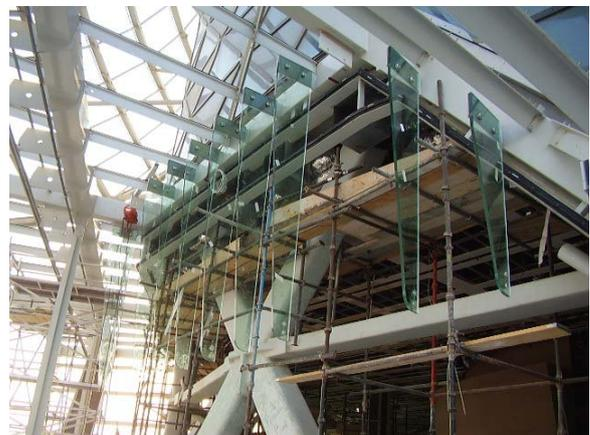
**Abb. 5.16** Links: Gesamtansicht der Main Canopy; Rechts: Glasschwerter im Bauzustand
