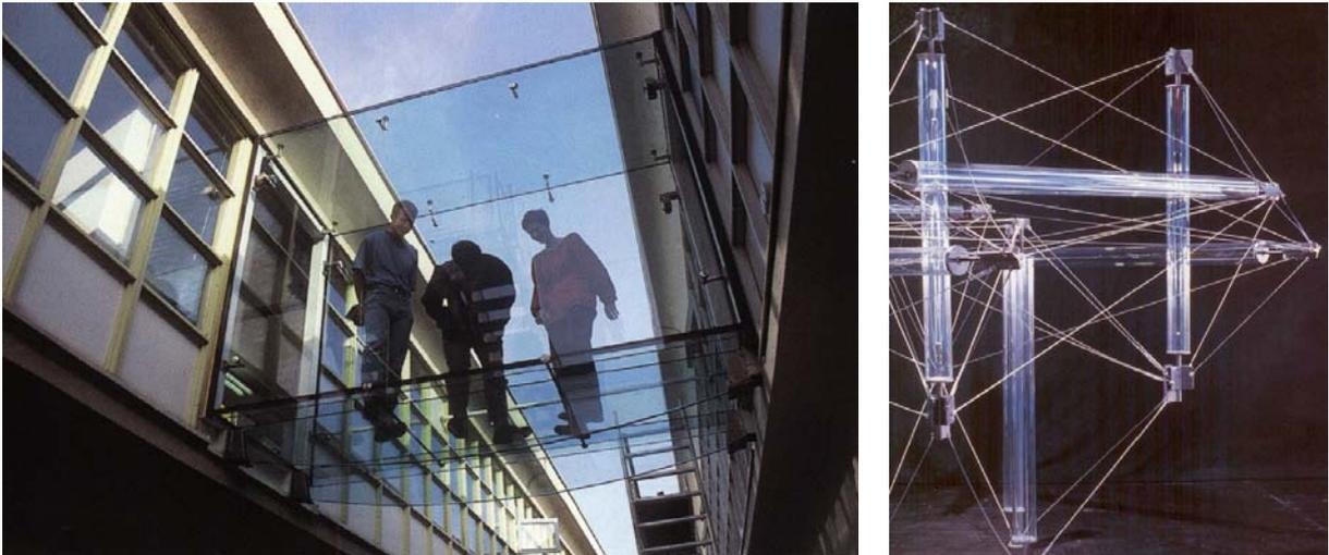
**Abb. 3.5** Links: Glasbrücke in Rotterdam - Träger aus Glas [7]; Rechts: Tensegrity-Skulptur - glasstec 1996 [2]
