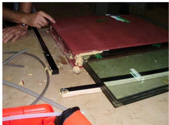
**Abb. 5.17** Links: Glasschwerter im Bauzustand; Rechts: Injizieren des Mörtels zwischen Glasschwerter und Stahlschuh
