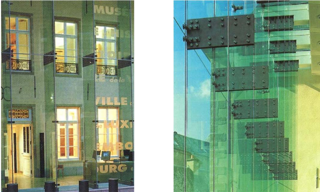
**Abb. 5.13** Links: Blick von aussen durch die Glaswand [7]; Detailansicht der Verbindung der Glasschwerter untereinander [10]
