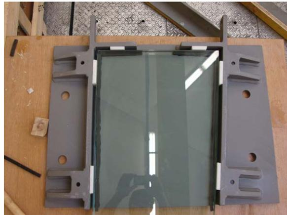
**Abb. 10.21** Einbau der Klotzungsblöcke
