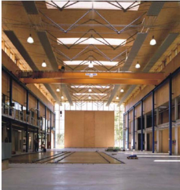
Abb. 2.5      unterspannte Dachkonstruktion des Bautechnikzentrums der TU Graz [1]
