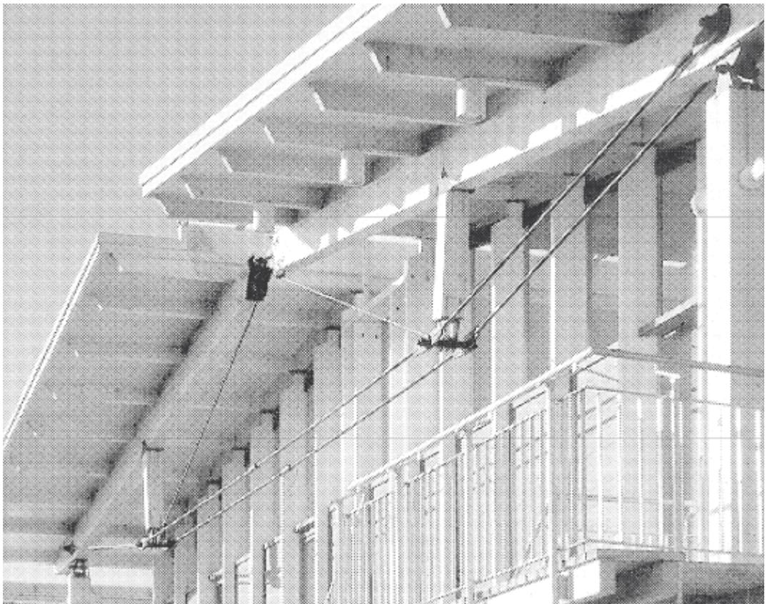
Abb. 2.1      Foto: unterspannter Holzträger des Holzinformationszentrums in Rheinstetten [4]
