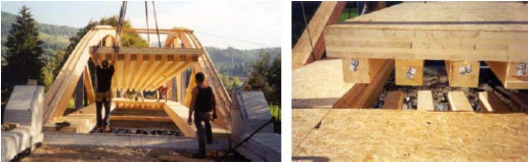
Abb. 2.3 Einsatz einer BSP-Platte im Brückenbau [2]
