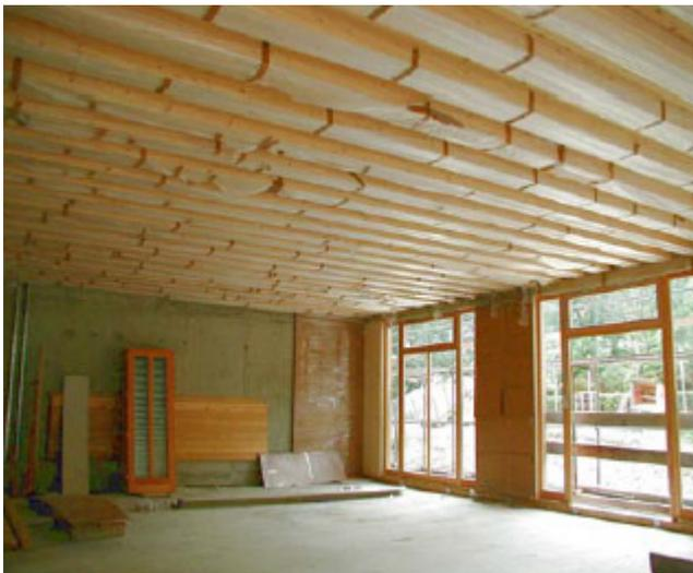
Abb. 2.4 Rippenplatte aus BSP/BSH [2]
