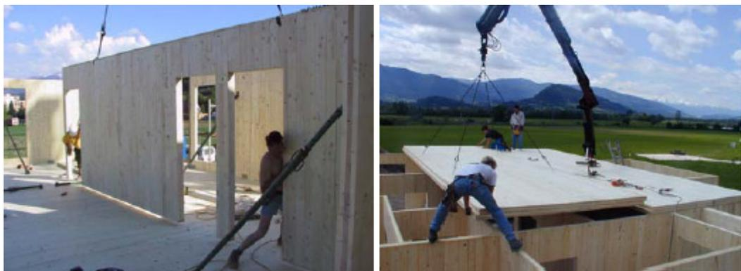
Abb. 2.1 Wand- und Deckenelemente aus BSP [2]
