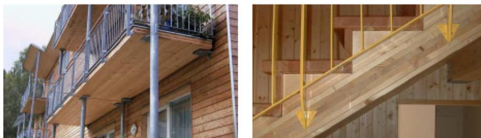
Abb. 2.2 Balkonplatte und Stiegenlaufplatte aus BSP [1]
