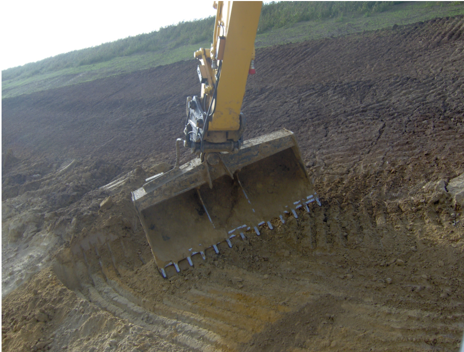
Abb. 6.10 Sicht aus der Baggerkabine 135
