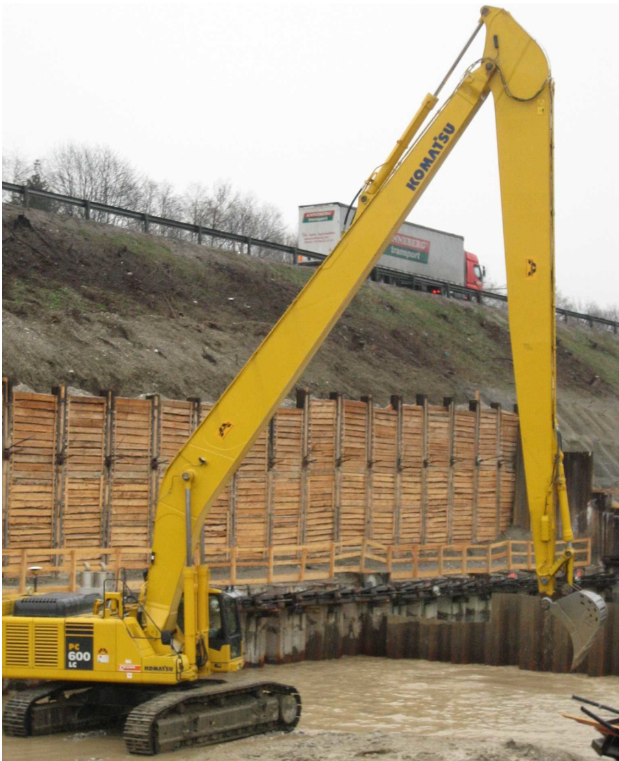
Abb. 6.25 GPS gesteuerter Langstielbagger im Unterwasseraushub (Entladen) 151
