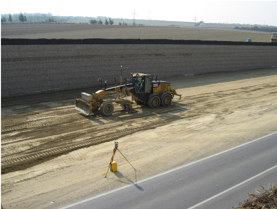
Abb. 6.17 Gradersteuerung mittels Totalstation 142
