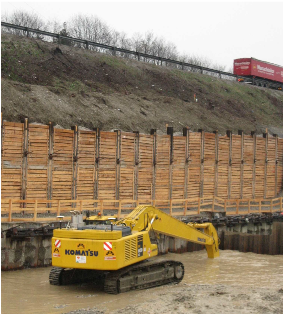
Abb. 6.24 GPS gesteuerter Langstielbagger im Unterwasseraushub 150
