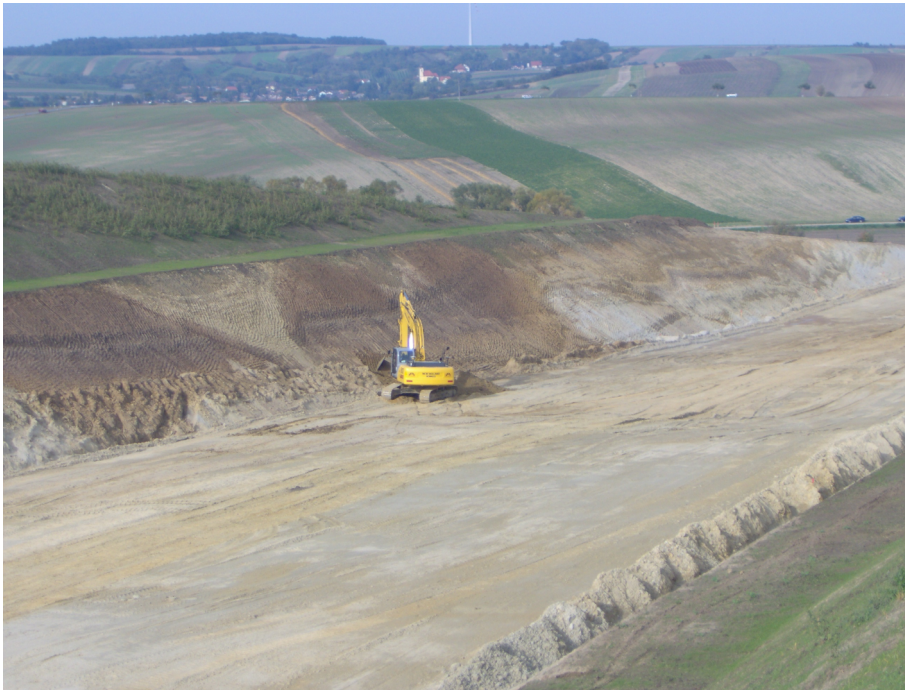
Abb. 6.29 Einschnittsfertigstellung mittels GPS gesteuertem Hydraulikbagger 155
