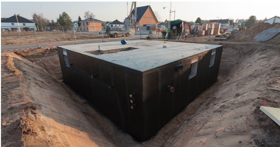
Abbildung 35: Abdichtung mit Schwarzer Wanne 195
