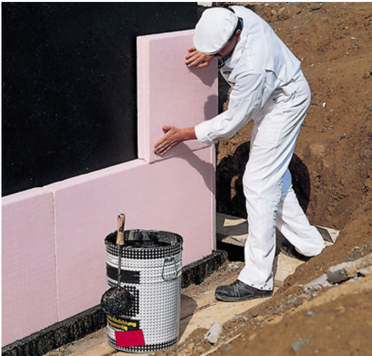
Abbildung 13: Perimeterdämmung mit XPS Dämmplatten 87
