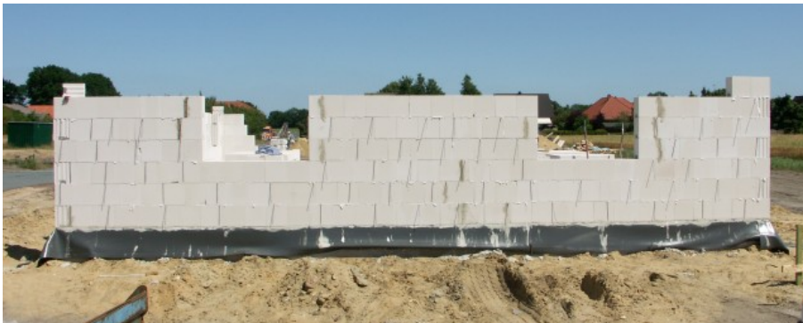
Abbildung 26: Horizontale Feuchtigkeitssperre 171
