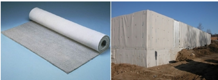
Abbildung 37: Bentonitbahnen am Bauwerk 211
