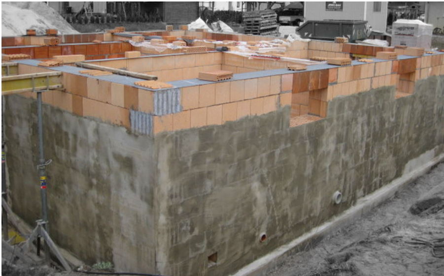
Abbildung 19: Keller mit Dichtungsschlämmen 124
