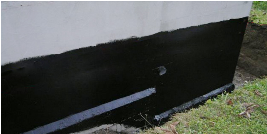
Abbildung 18: Bitumenanstrich im Perimeterbereich 111
