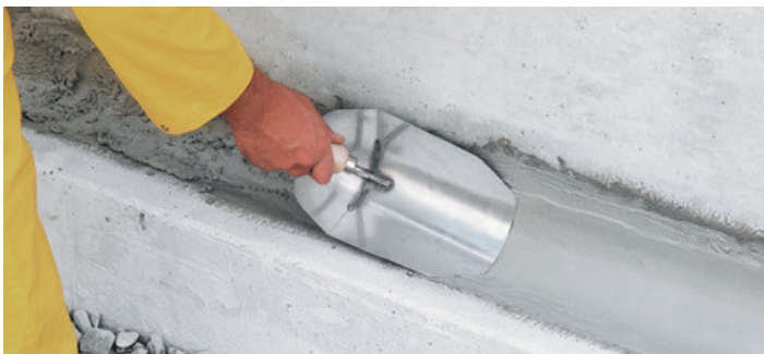
Abbildung 22: Herstellung einer Hohlkehle 146
