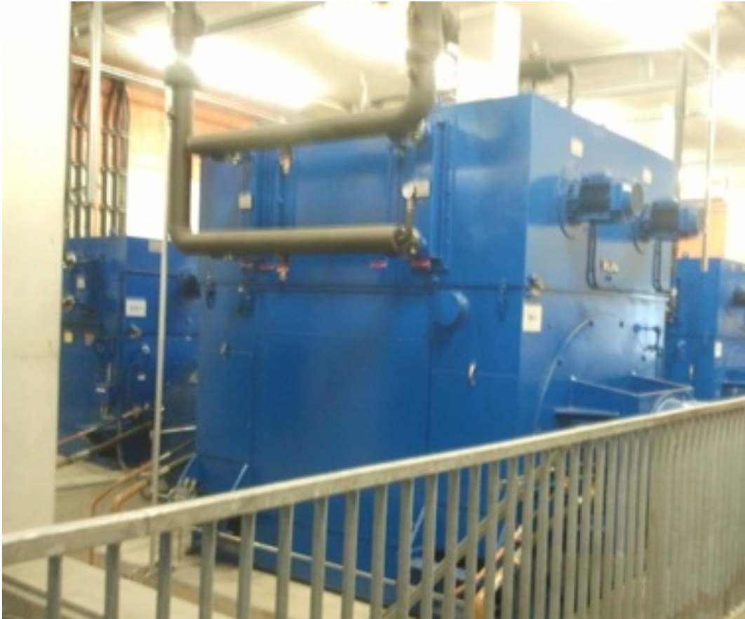
Abbildung 4.1.: Synchronmaschine, welche für die Berechnungen und den Hochlaufversuch herangezogen wurde.
