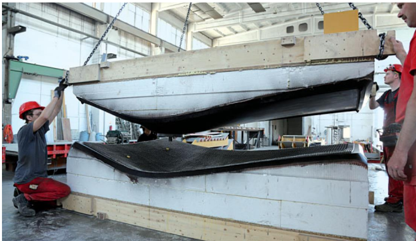
Abbildung 8 – Zwei Schalungshälften bei der Herstellung der Parapluie
