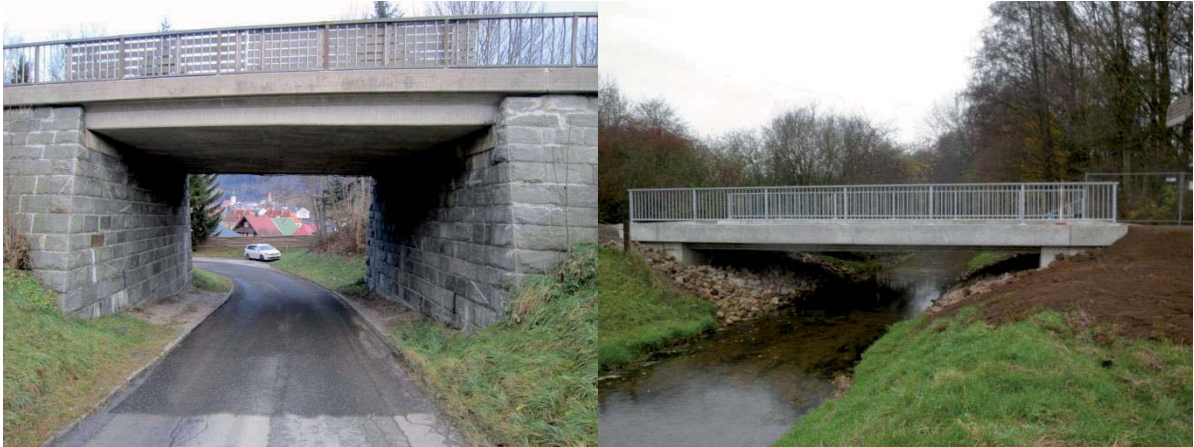
Abbildung 2: konventionelles Brückentragwerk (li); integrale Brücke 1 (re)
