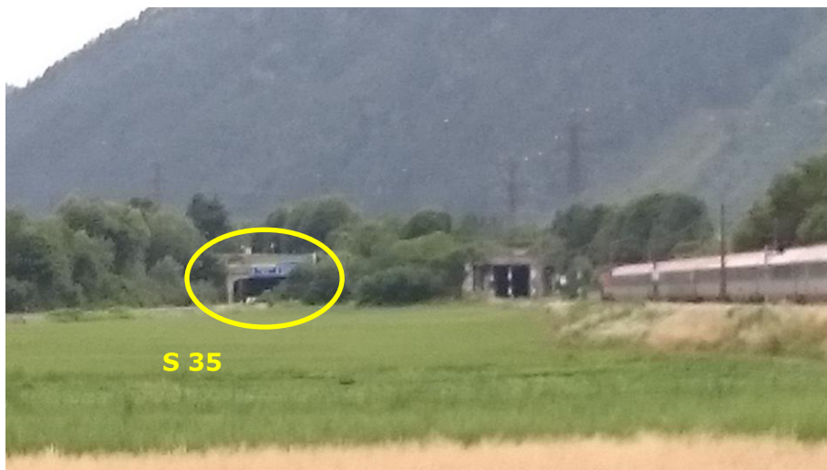
Abbildung 32: Ansicht Unterführung Deutsch-Feistritz vom Norden [11]
