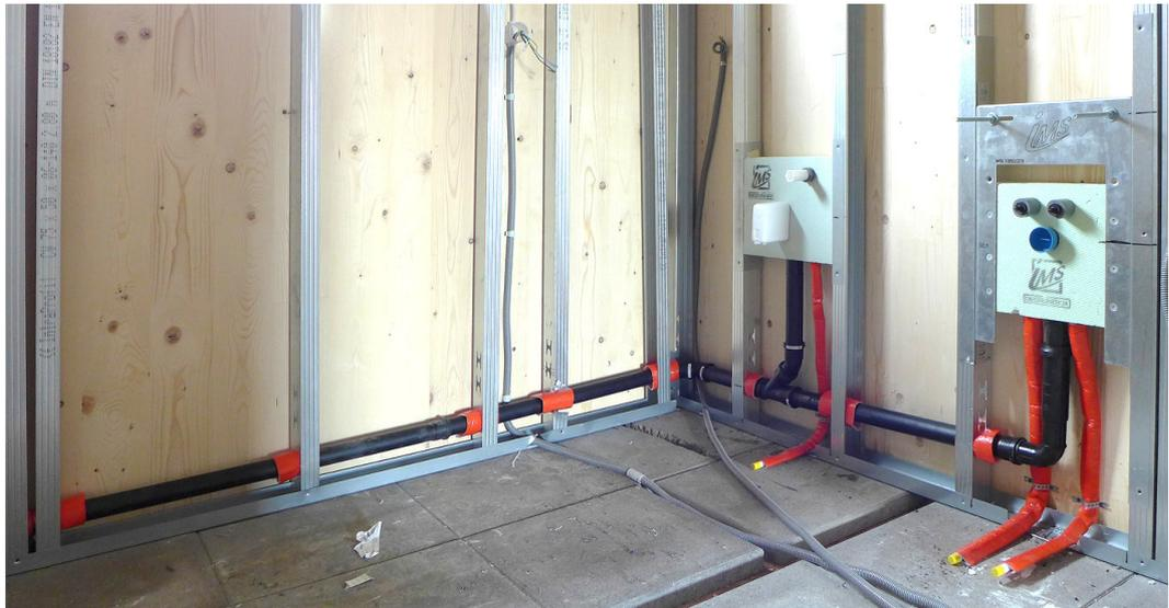
Abb. 3.15 Vorwandinstallation mit Montagegerüst zur Befestigung eines Waschbeckens und Anschluss einer Waschmaschine
