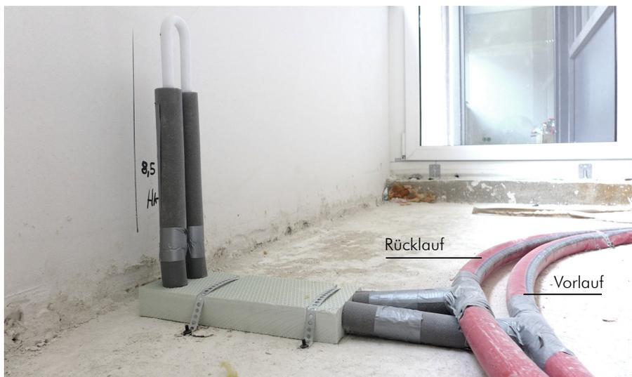
Abb. 8.3 Zweirohrsystem mit Anschluss an einen Heizkörper (STB-Massivbauweise)
