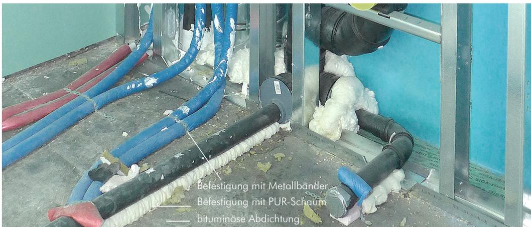
Abb. 4.6 Ausbildung einer Fußbodenabdichtung in einem Sanitärzimm (Wannenausbildung)
