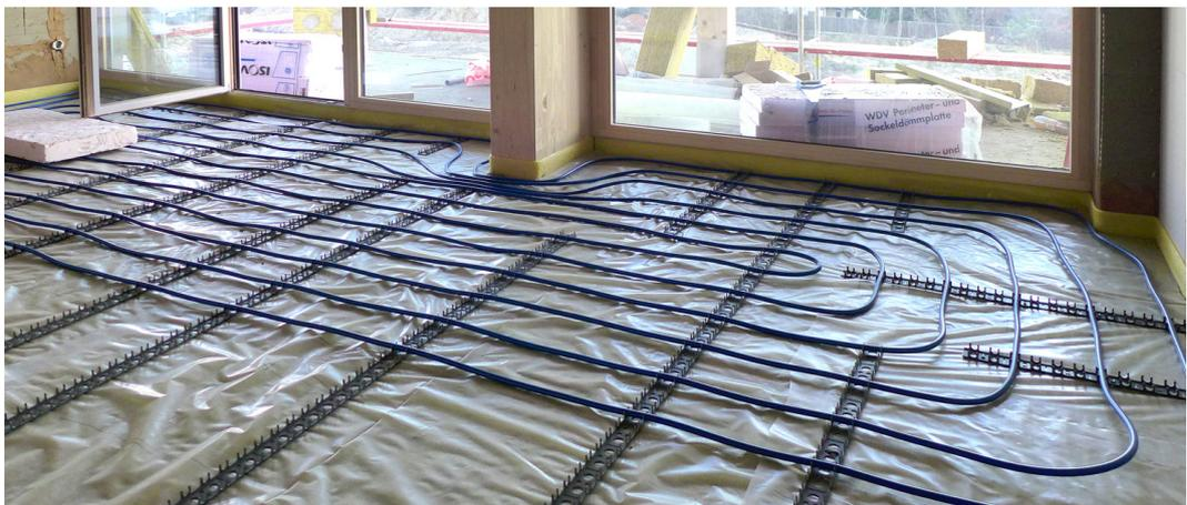
Abb. 8.10 Röhrenregister einer Fußbodenheizung befestigt auf Montageschienen
