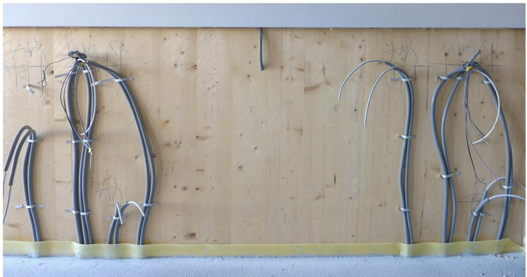
Abb. 3.16 Vorwandinstallation aus Gipskartonplatten zur Führung der Elektroinstallation
