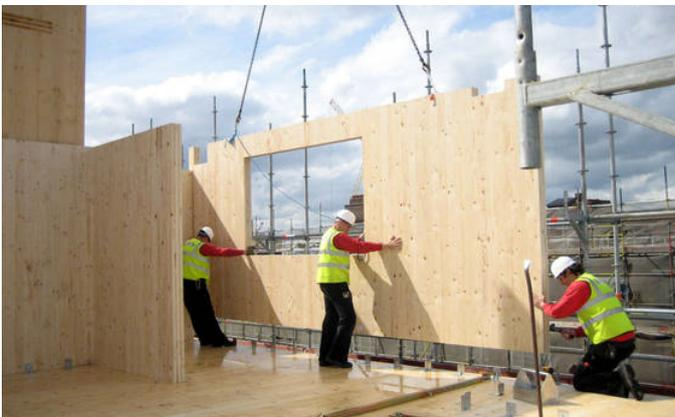
Abb. 2.4 Montage eines Wandelements in BSP, [103]
