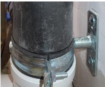
Abb. 4.24 Distanzhalter zur Befestigung von wasserführenden Leitungen
