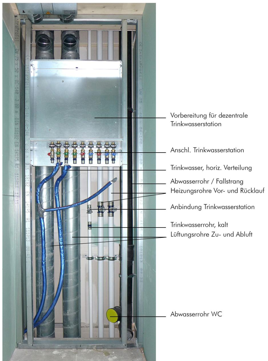
Abb. 3.2 vertikaler Installationsschacht für HKLS-Installationen im WC-Raum
