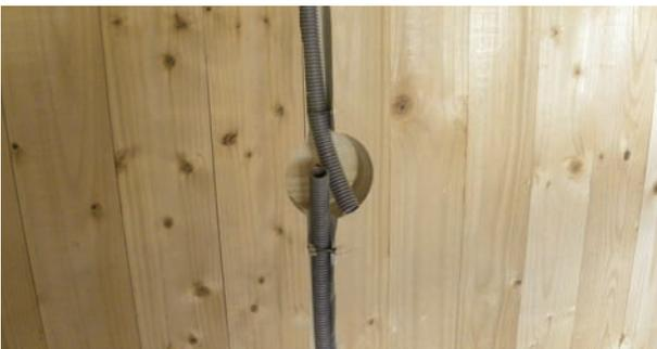
Abb. 3.9 vertikale Fräsung für Installation in einem Wandelement, [17]
