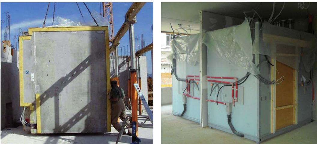
Abb. 3.26 vorgefertigte Sanitärzellen Firma Sanitär Elementbau GmbH, [90]
