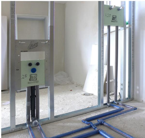
Abb. 3.13 Fertigteil-Montagesysteme der Firma IMS Handels GmbH (Graz) für die Installation einer Dusche und eines Waschtisches in einer Metallständerwand
