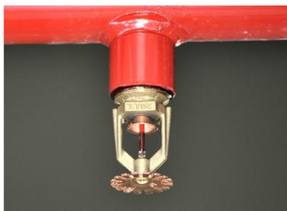
Abb. 6.1 Sprinklerkopf, angeschlossen an das Leitungsnetz [107]
