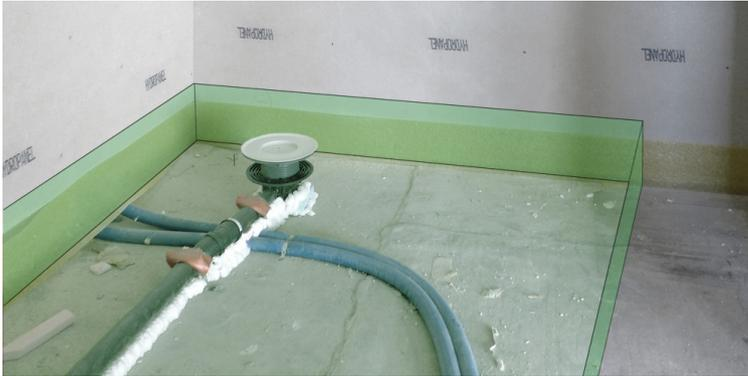
Abb. 4.8 mögliche Ausführung einer lokalen Abdichtungswanne für den Wannenabfluss in der Ebene der Schüttung
