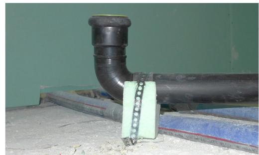
Abb. 3.21 Abstandhalter und Metallbänder zur Befestigung diverser Installationen
