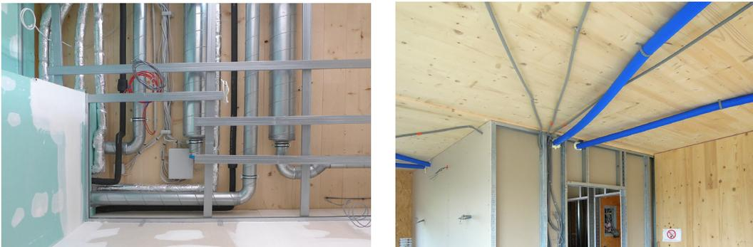
Abb. 3.22 links: Heizungs-, Lüftungs- und Sanitärinstallationen in abgehängter Decke (Sanitärraum)
