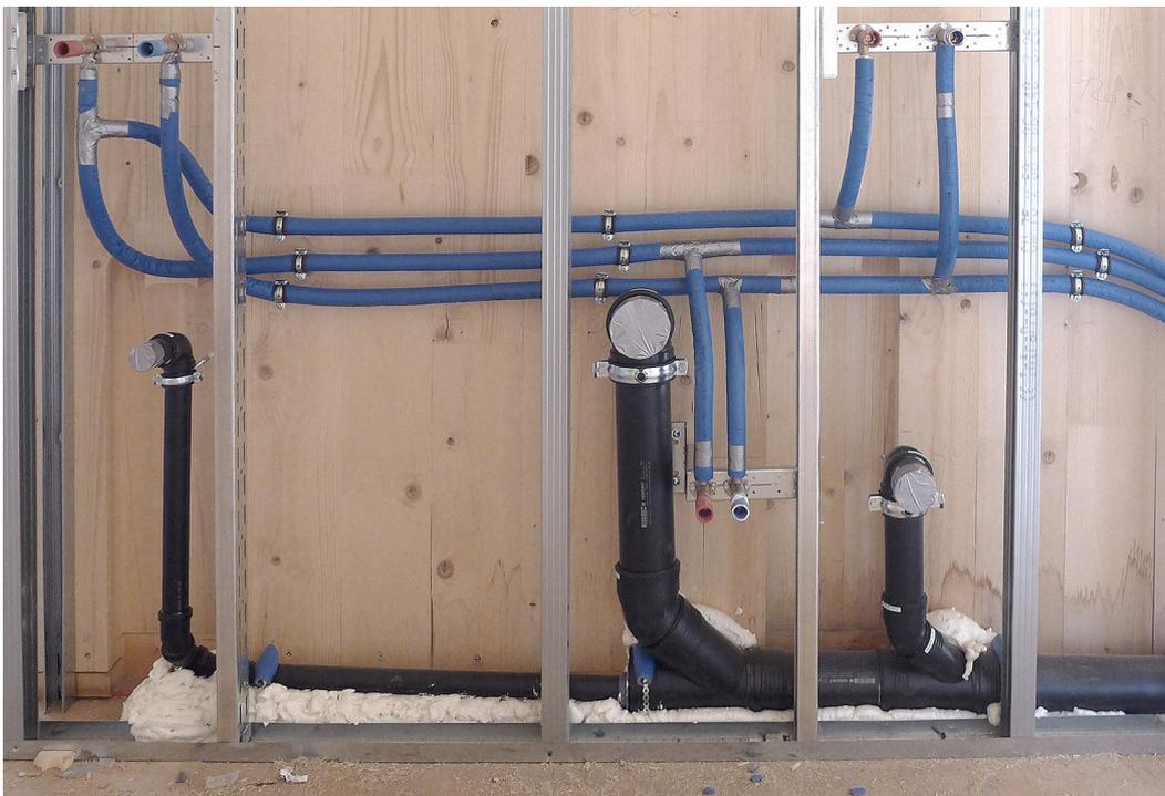
Abb. 3.14 Vorwandinstallationen einer Arztpraxis an einer BSP-Trennwand
