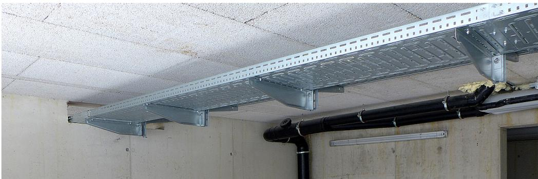
Abb. 3.23 sichtbare Abwasserrohre und Leitungstrasse im Kellergeschoß
