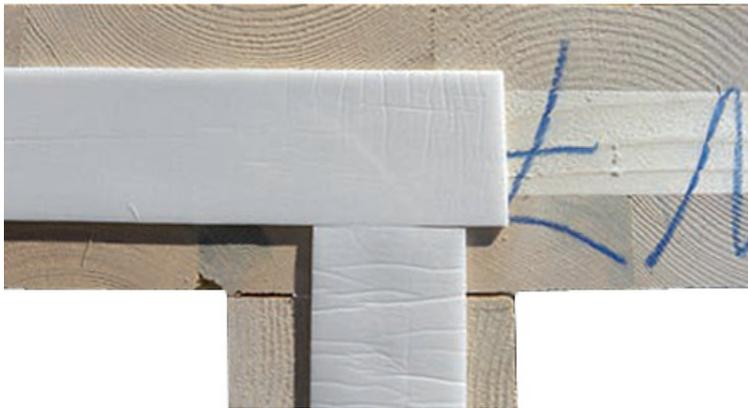
Abb. 2.6 Dichtband zur Sicherstellung der Luftdichtheit der Gebäudehülle, [17]
