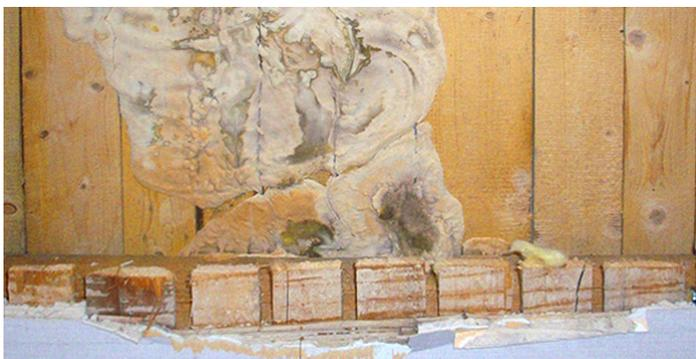
Abb. 2.1 Befall einer Wohnungstrennendecke mit einem Hausschwamm infolge geringer aber beständiger Feuchteeinwirkung, [115]
