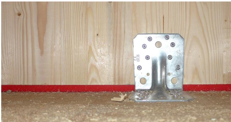
Abb. 2.7 Elastomerlager zur Minimierung der Körperschallübertragung
