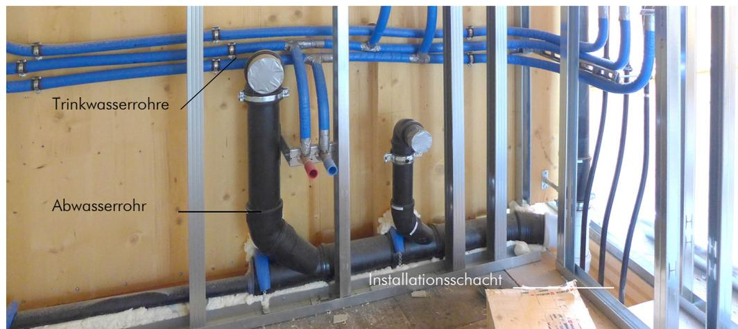
Abb. 4.16 Installationswand einer Arztpraxis mit integriertem Installationsschacht
