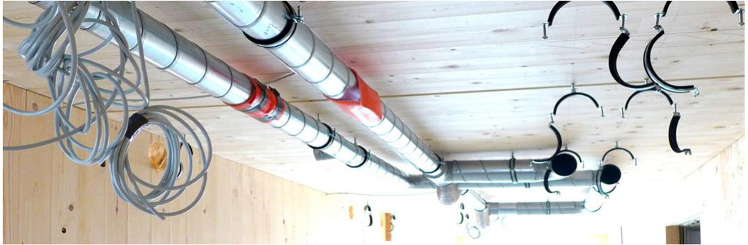
Abb. 10.4 Verlegung der Lüftungsrohre in einer abgehängten Decke
