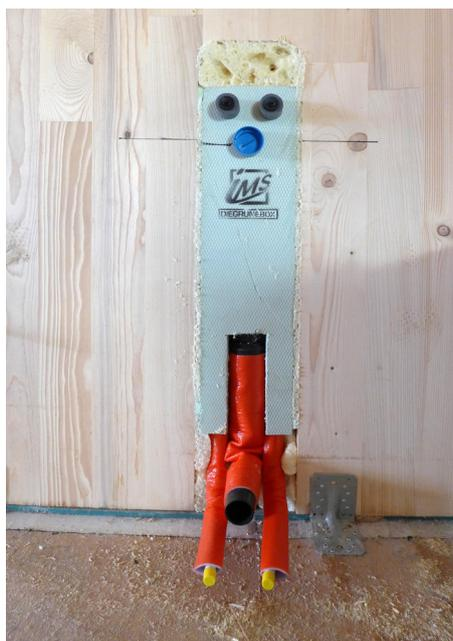
Abb. 3.7 in Aussparung montierte Installationsbox für den Anschluss eines Waschbeckens
