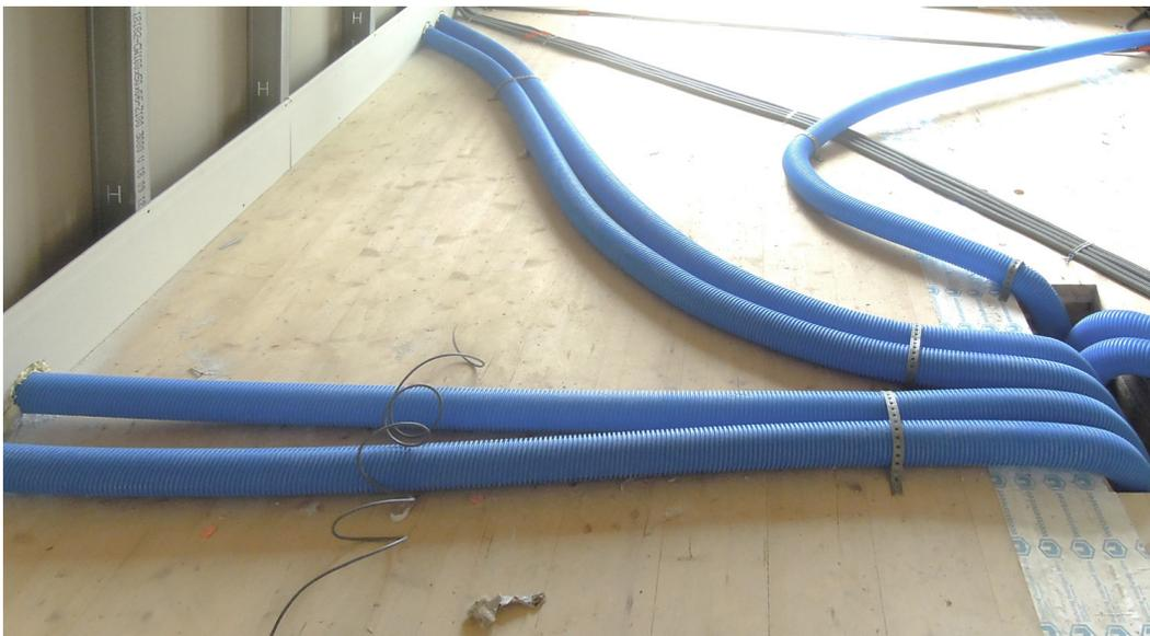
Abb. 10.3 Kunststoff-Luffungsrohre in der Ebene der Schuttung verlegt
