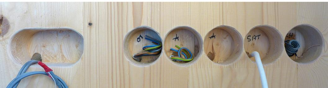
Abb. 3.10 Elektroinstallationen in einem BSP-Element in Sichtqualität
