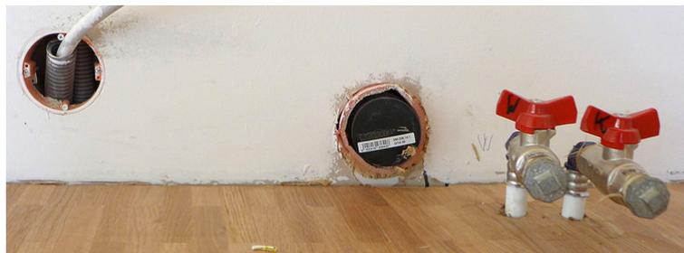
Abb. 4.1 Kalt- und Warmwasserzuleitungen sowie Abwasserleitung zum Anschluss einer Küche
