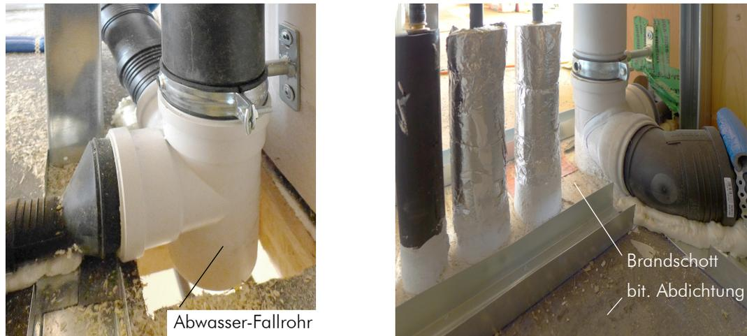
Abb. 4.1 konventionelle Ausbildung eines vert. Schachtes vor Einbringen des Brandschotts, (li) Verhinderung eines Brandüberschlags mit Hilfe eines Brandschotts, (re)
