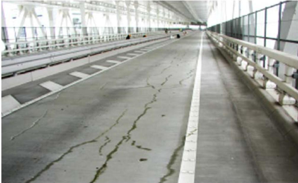
**Abbildung 2.21:** Risse in der Fahrbahnoberfläche der YBB [15]
