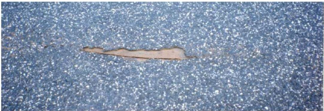
**Abbildung 1.2:** Riss im Dünnbettbelag und dem darunter liegenden Deckblech [1]
