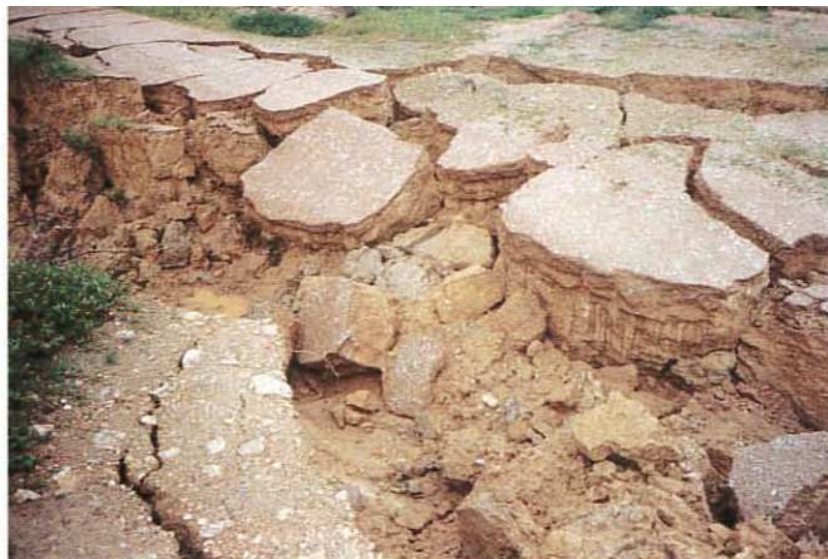
Abb. 2 Aufsprengen der Oberfläche aufgrund von Sandkegeln während des Izmit-Erdbebens in der Türkei 1999 (Day, 2002, Bild aus Izmit Collection, EERC, University of California, Berkeley)
