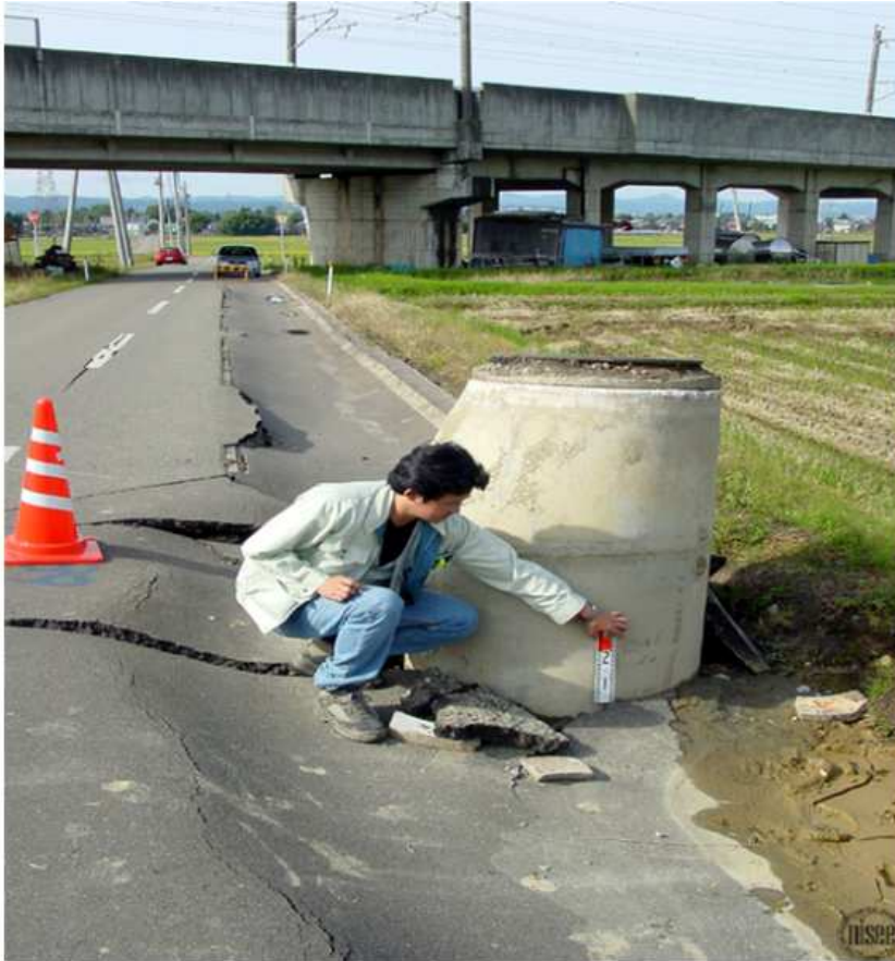
Abb. 4 Aufschwimmen eines Kanalschachts nach dem Niigata-Ken Chuetsu Erdbeben im Bezirk Niigata, Japan, 2004 (Buchheister, 2012, Bild von Bardet, J.-P, The Earthquake Engineering Online Archive, Bild NM0018)
