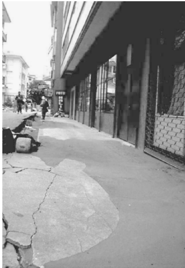
Abb. 2 Aufsprengen der Oberfläche aufgrund von Sandkegeln während des Izmit-Erdbebens in der Türkei 1999 (Day, 2002, Bild aus Izmit Collection, EERC, University of California, Berkeley)
