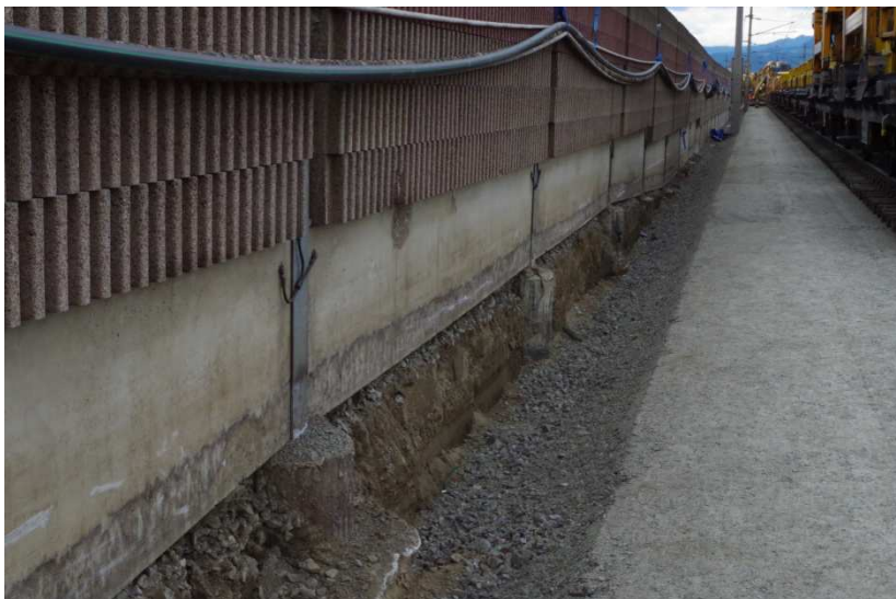
Abbildung 56 Neulage Schwelle nach Einbau LSW 35
