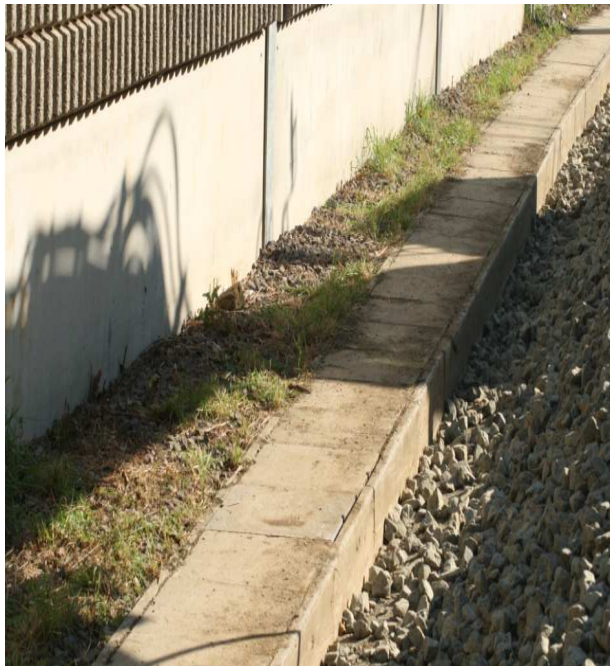
Abbildung 2 Mangelhafte Entwässerung 9
