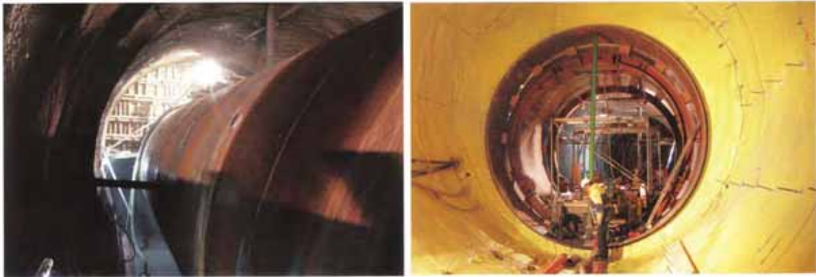
Abbildung 4.38: linkes Bild: Stahlpanzerung in der Drossenquerung; rechtes Bild: Folienabdichtung des Übergangsbereiches 65
