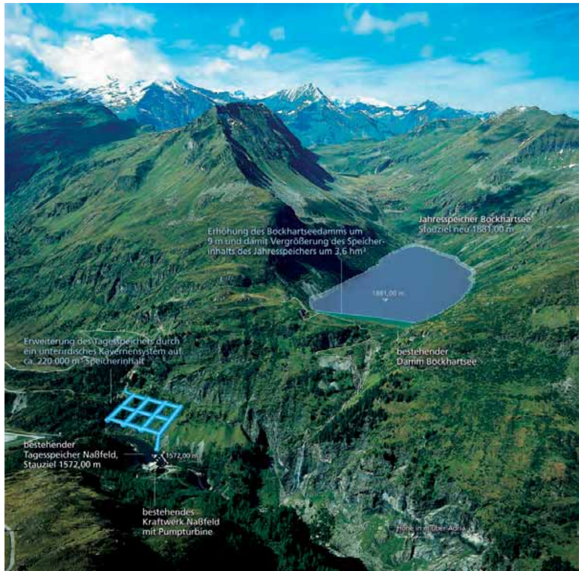
Abbildung 4.24: PSW-Naßfeld: Luftbild des Anlagenbestandes und der durchgeführten Baumaßnahmen 42
