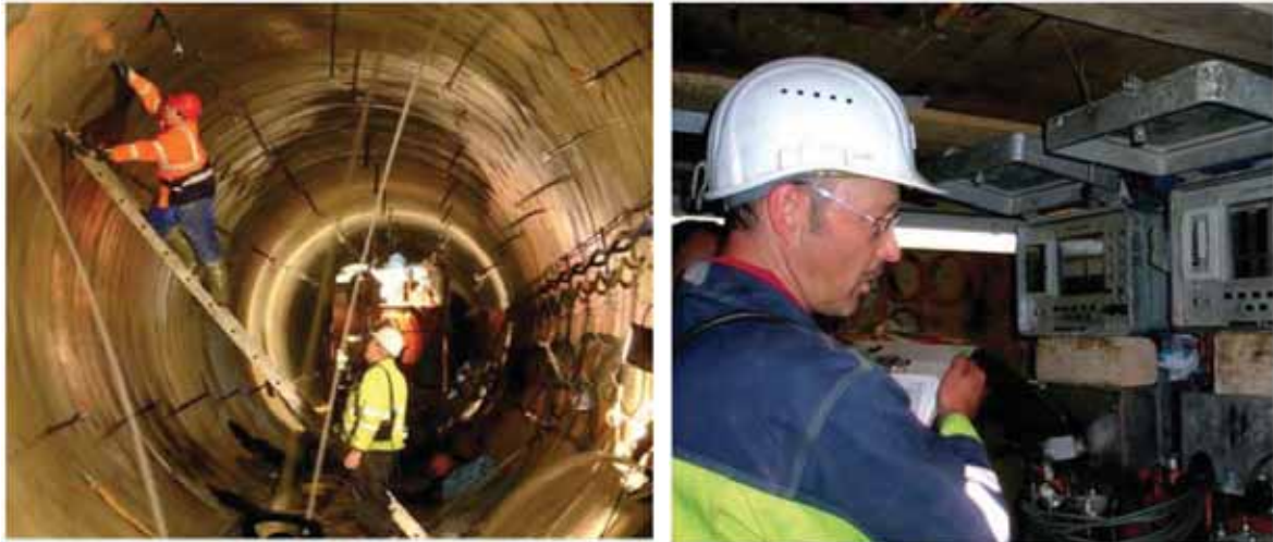
Abbildung 4.10: Ausführung der Injektionsarbeiten im Druckstollen des PSW Kops II 17
