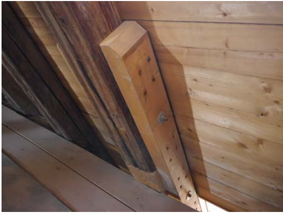
Abb. 5.33: Links: Instandsetzung eines Sparren mittels Anlaschung (Alter Hof, München); Rechts: Instandsetzung der Sparren mittels Anlaschung und Aussteifung des Dachtragwerkes (Schloss Greifenstein, Niederösterreich)
