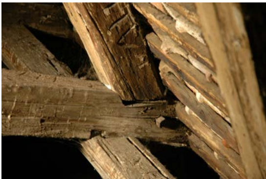
Abb. E.4: Links: Weißschwanz bei Kehlbalken - Sparren (Graz, Hofgasse 10); Rechts: Weißschwanz bei Kehlbalken - Sparren (Graz, Färbergasse 11)
