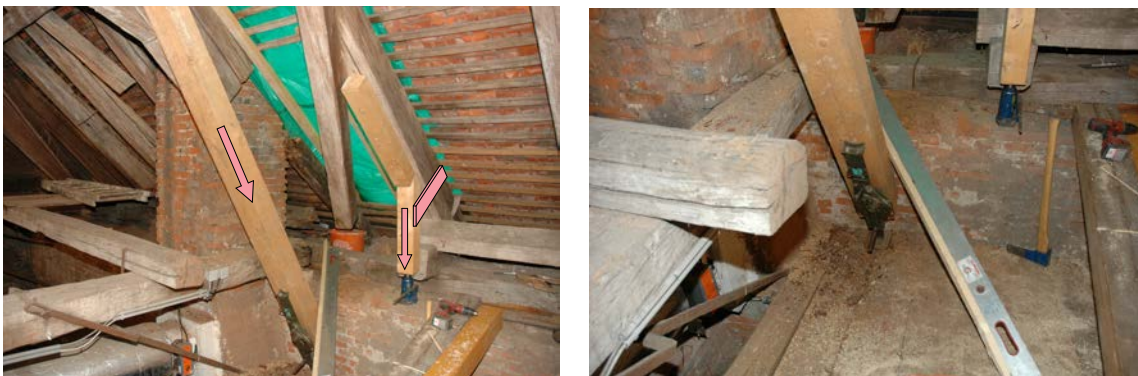
Abb. 5.10: eingebrachte Konstruktion zum Anheben des Bestandes (FOTO: ANDREAS MEISEL)
