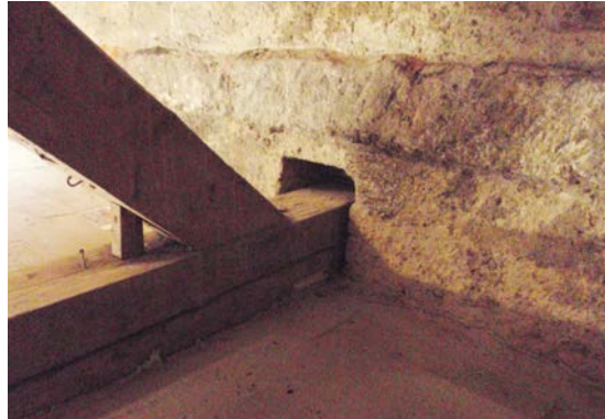
Abb. E.6: Links: zerstörtes Dippelbaumaufleger (Graz, Sackstrasse 16); Rechts: luftumspültes Bundtramaufleger (Graz, Marburgerkai 49)
