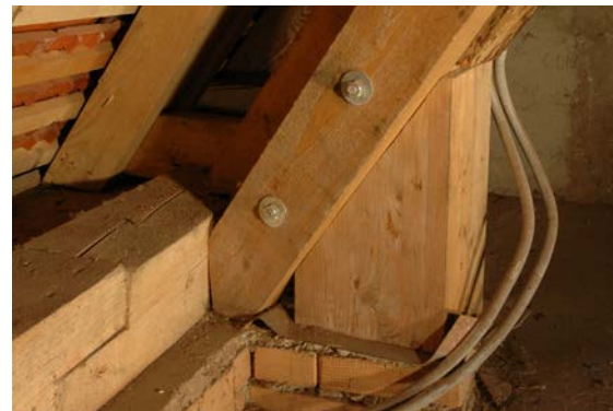
Abb. 5.6: Links: fehlende Horizontalkrafteinleitung in das Mauerwerk (Palais Herberstein, Graz); Rechts: unfachgemäß instandgesetzter Fußpunktbereich eines Kehlbalkendachs (Graz, Hofgasse 10A)
