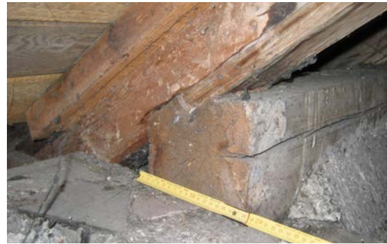
Abb. E.3: Klaue bei Sparren - Mauerbank (Graz, Färbergasse 11); Rechts: Gaißfuß bei Sparren - Mauerbank (Graz, Färbergasse 11)
