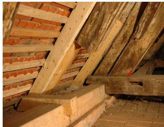
Abb. 5.5: Links: Instandgesetzter Sparrenfußpunkt mittels Kanthölzern und Eisenklammern (Palais Herberstein, Graz); Rechts: unfachgemäße Fußpunktinstandsetzung eines Leergespärres (Graz, Hofgasse 10A)
