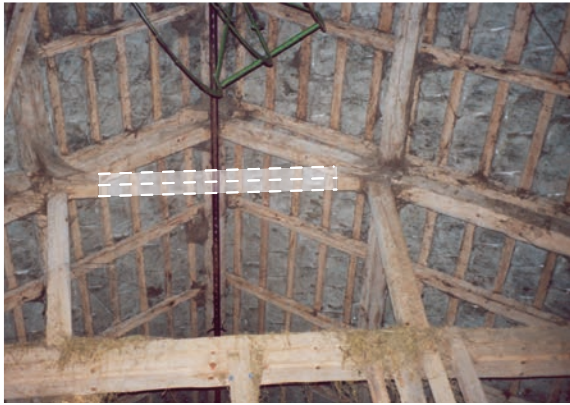
Abb. 3.14: Links: für einen Heukran entfernter Druckriegel (Forstamt 15); Rechts: für eine Kamindurchführung gekappter Wechselbalken und entfernte Strebe (Schloss Söding)
