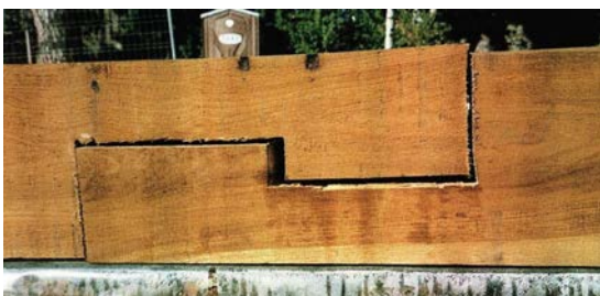
Abb. 5.7: Links: Längsstoß mittels Hakenblatt (ERLER (2004) S. 153); Rechts: Sparreninstandsetzung durch geraden Stoß und Anlaschung (Anonym)
