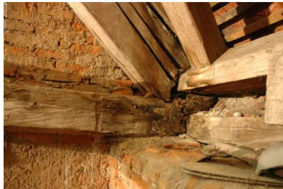
Abb. 5.27: Links: Schaden am Fußpunkt aufgrund von Pilzbefall (Kehlbalkendach – Alte Universität, Graz); Rechts: aus Sicht der Denkmalpflege korrekt sanierter Fußpunkt (Kehlbalkendach – Alte Universität, Graz)
