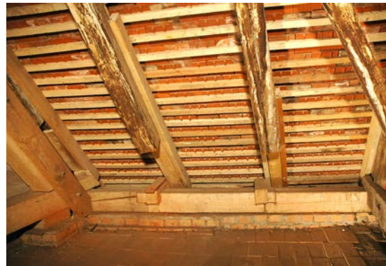
Abb. 5.2: Links: Mauerbankinstandsetzung mittels schrägem Stoß (Anonym); Rechts: instandgesetzter Fußpunktbereich eines Kehlbalkendachs mit zweifach liegendem Stuhl (Graz, Hofgasse 10A)
