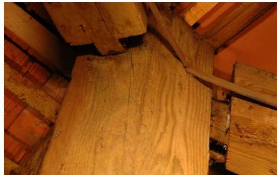
Abb. E.1: Links: durch Pilz zerstörter Fußpunkt (Graz, Sackstrasse 16); Rechts: Fersenversatzzapfen am Firstpunkt (Graz, Färbergasse 11)
