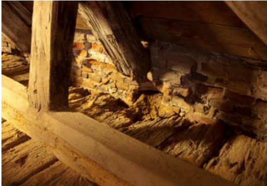
Abb. E.6: Links: zerstörtes Dippelbaumaufleger (Graz, Sackstrasse 16); Rechts: luftumspültes Bundtramaufleger (Graz, Marburgerkai 49)
