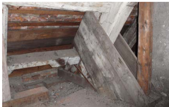
Abb. E.2: Links: Schaden durch Pilzbefall (Graz, Färbergasse 11); Rechts: Vernagelung Fußpunkt (Graz, Sackstrasse 16)
