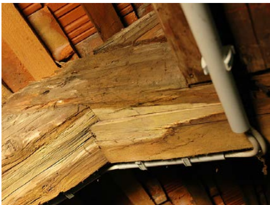
Abb. 5.34: Links: Bruch eines Weißschwanzblattes aufgrund Rollschubversagen (Ferdinandum, Graz); Rechts: zerstörter Firstpunkt aufgrund Pilzbefall (Schloss Hainfeld, Feldbach)
