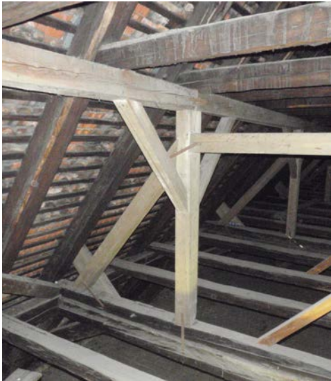
Abb. 4.4: Links: doppeltes Hängewerk als additive Instandsetzungsmaßnahme (Landeszeughaus, Graz); Rechts: Instandsetzung einer Kamindurchführung mittels additiver Bauteile (Lessingstrasse 27, Graz)
