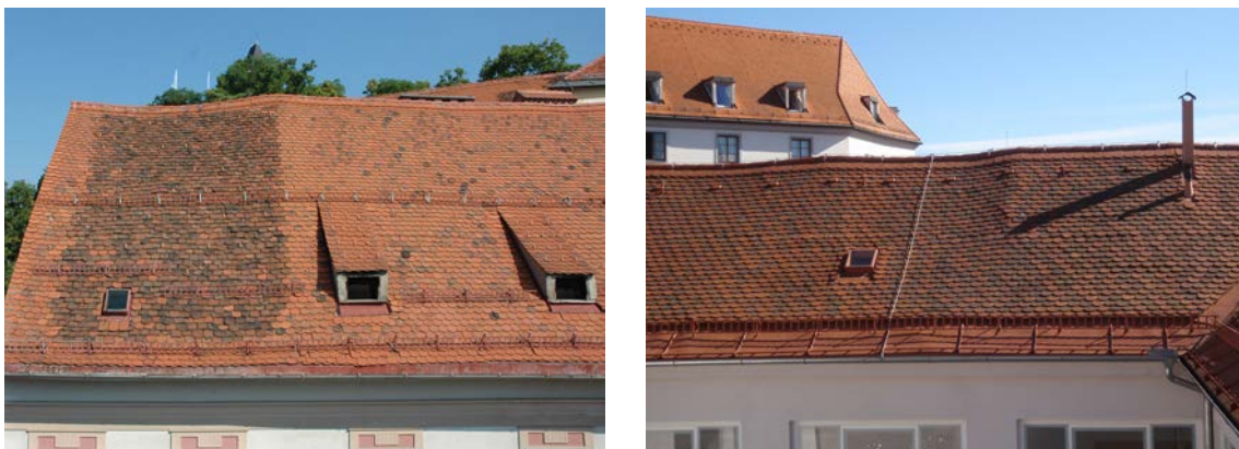
Abb. 5.1: starke Verformungen an Dachtragwerken der Grazer Dachlandschaft (FOTO ANDREAS MEISEL)
