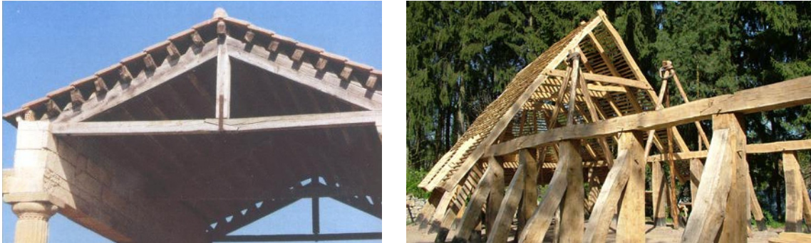
Abb. 1.2: Links: römisches Pfettendach (vgl. ERLER (2004) S. 140); Rechts: frühmittelalterliches Sachsenhaus – Germanisches Sparrendach (FOTO ROELAND PAARDEKOOPEER)
