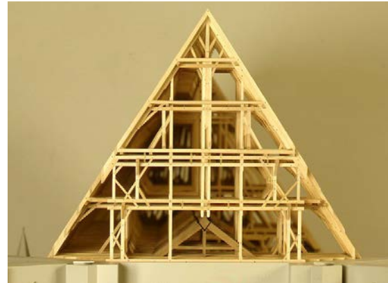
Abb. 2.41: Dachtragwerk der Liebfrauenmünster – Kirche in Ingolstadt/Deutschland im Maßstab 1:50. Die Konstruktion stammt aus dem Jahre 1491/1492 und überspannt eine Gesamtbreite von 31 Metern und weist eine Höhe von 25 Metern auf (Foto: BÜRGERSERVICE-PORTAL STADT INGOLSTADT)
