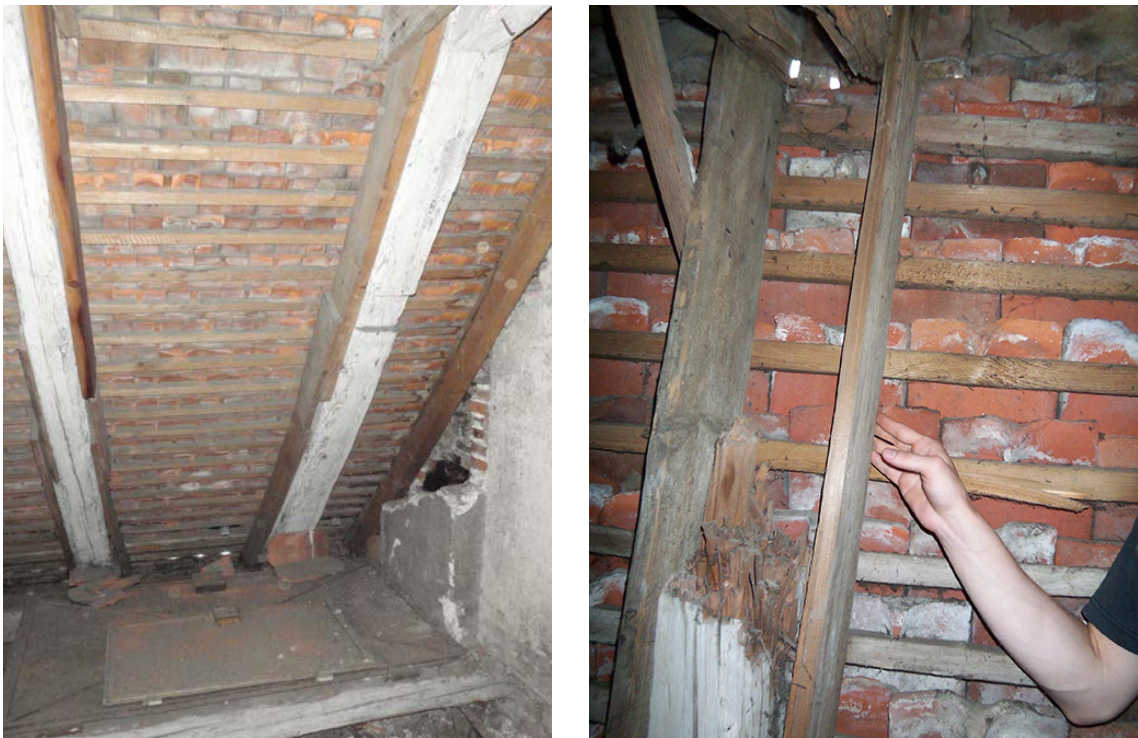
Abb. 5.32: unfachgemäße Instandsetzungen eines Sparren mittels Aufdopplung bzw. Anlaschung (Schloss Hainfeld, Steiermark)
