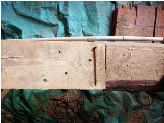
Abb. 4.9: unfachgemäße Instandsetzung eines Bundtrames mittels stehendem Blatt (Anonym)
