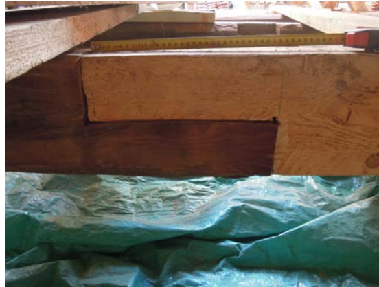
Abb. 4.9: unfachgemäße Instandsetzung eines Bundtrames mittels stehendem Blatt (Anonym)
