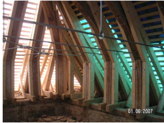
Abb. 5.33: Links: Instandsetzung eines Sparren mittels Anlaschung (Alter Hof, München); Rechts: Instandsetzung der Sparren mittels Anlaschung und Aussteifung des Dachtragwerkes (Schloss Greifenstein, Niederösterreich)
