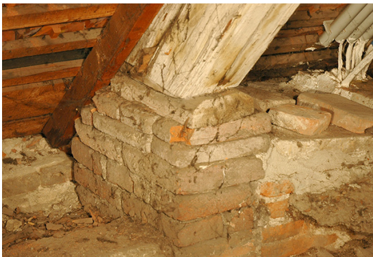
Abb. 5.6: Links: fehlende Horizontalkrafteinleitung in das Mauerwerk (Palais Herberstein, Graz); Rechts: unfachgemäß instandgesetzter Fußpunktbereich eines Kehlbalkendachs (Graz, Hofgasse 10A)
