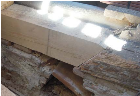
Abb. 5.2: Links: Mauerbankinstandsetzung mittels schrägem Stoß (Anonym); Rechts: instandgesetzter Fußpunktbereich eines Kehlbalkendachs mit zweifach liegendem Stuhl (Graz, Hofgasse 10A)
