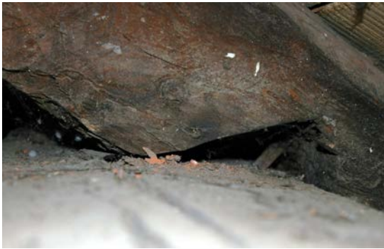
Abb. E.3: Klaue bei Sparren - Mauerbank (Graz, Färbergasse 11); Rechts: Gaißfuß bei Sparren - Mauerbank (Graz, Färbergasse 11)
