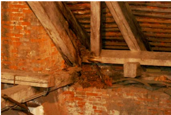
Abb. 5.27: Links: Schaden am Fußpunkt aufgrund von Pilzbefall (Kehlbalkendach – Alte Universität, Graz); Rechts: aus Sicht der Denkmalpflege korrekt sanierter Fußpunkt (Kehlbalkendach – Alte Universität, Graz)
