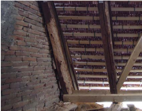
Abb. 4.7: Links: bebelte Stuhlsäule (Schloss Moosbrunn, Graz); Rechts: loser Holznagel (Franziskanerkirche, Graz)
