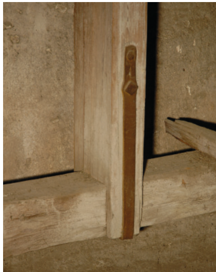
Abb. 2.18: Beispiel zur Anwendung eines schmiedeeisernen Bandes (ALTE UNIVERSITÄT GRAZ)
