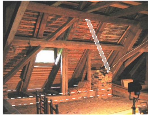
Abb. 3.14: Links: für einen Heukran entfernter Druckriegel (Forstamt 15); Rechts: für eine Kamindurchführung gekappter Wechselbalken und entfernte Strebe (Schloss Söding)
