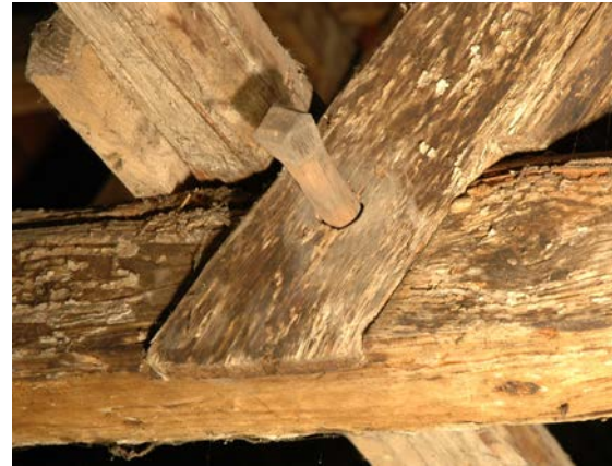
Abb. 4.7: Links: bebelte Stuhlsäule (Schloss Moosbrunn, Graz); Rechts: loser Holznagel (Franziskanerkirche, Graz)
