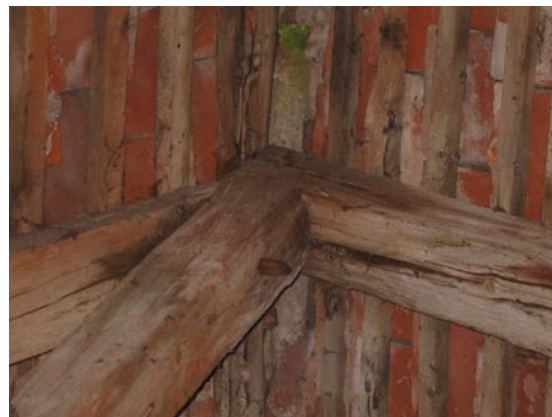
Abb. 5.34: Links: Bruch eines Weißschwanzblattes aufgrund Rollschubversagen (Ferdinandum, Graz); Rechts: zerstörter Firstpunkt aufgrund Pilzbefall (Schloss Hainfeld, Feldbach)
