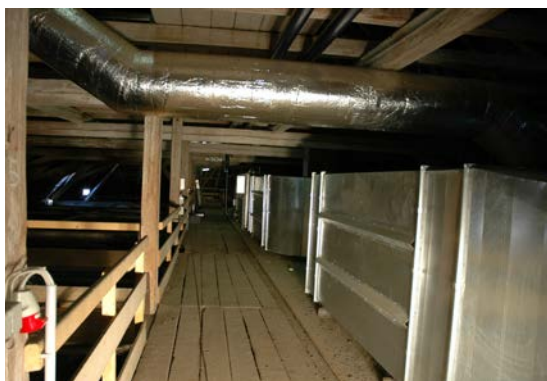
Abb. 4.2: Links: Einbauten der Klimaaggregate auf Bundtrame abgestellt (Alte Universität – Graz); Rechts: Warnhinweistafel zur maximalen Belastungsgrenze (Zeughaus – Graz)
