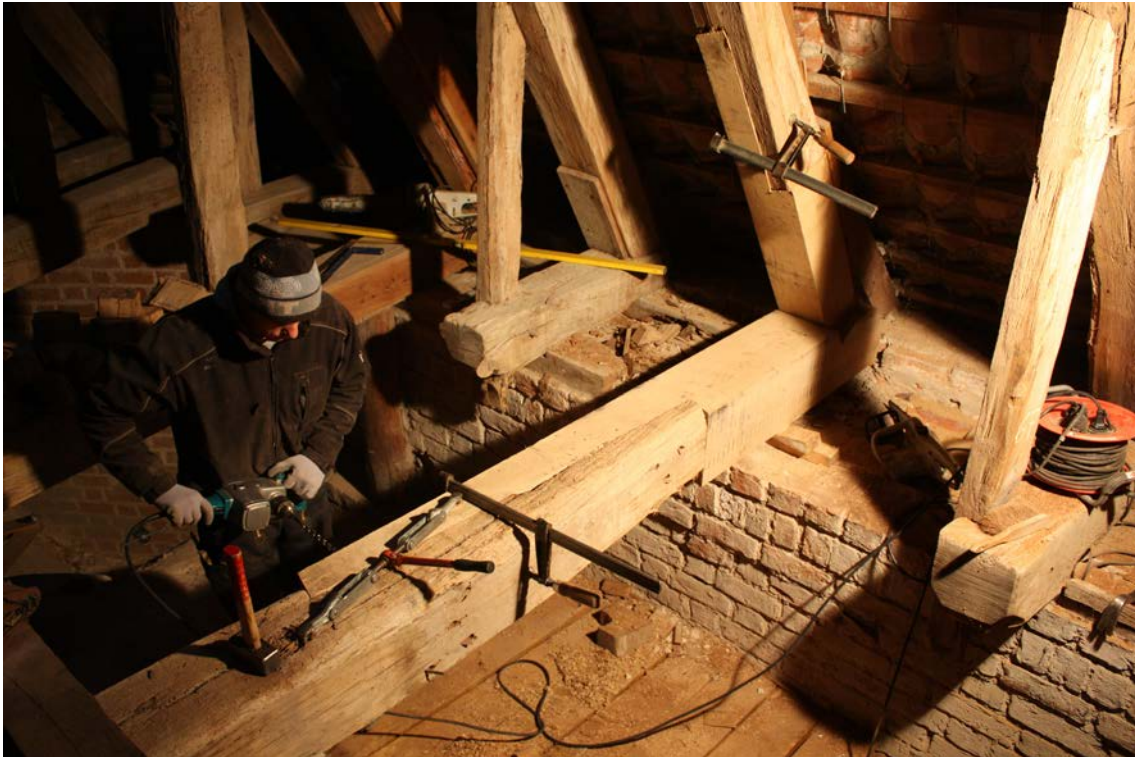
Abb. 5.30: fachmännische Instandsetzung eines Bundtrames mittels schräger Überblattung mit schrägem Stoß (FOTO: NORDKURIER)
