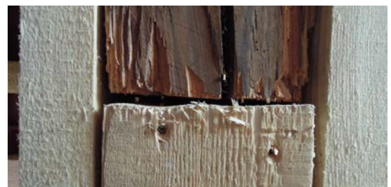
Abb. 5.7: Links: Längsstoß mittels Hakenblatt (ERLER (2004) S. 153); Rechts: Sparreninstandsetzung durch geraden Stoß und Anlaschung (Anonym)
