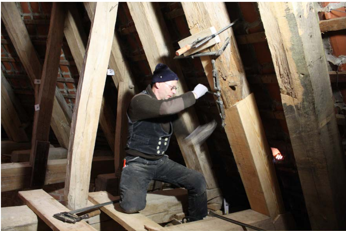
Abb. 5.31: fachmännische Instandsetzung eines Sparren mittels geradem Blatt und schrägem Stoß (FOTO: NORDKURIER)
