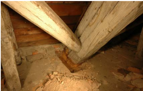
Abb. E.1: Links: durch Pilz zerstörter Fußpunkt (Graz, Sackstrasse 16); Rechts: Fersenversatzzapfen am Firstpunkt (Graz, Färbergasse 11)
