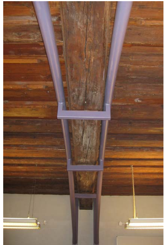
Abb. 4.5: substituäre Instandsetzung mittels Unterfangung der Deckenbalken einer Holztramdecke (Alte Universität, Graz)
