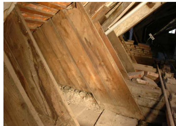
Abb. 5.4: Instandsetzung durch Vernagelung mit Brettern zur horizontalen Lasteinleitung (Palais Herberstein, Graz)
