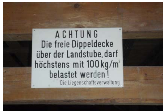
Abb. 4.2: Links: Einbauten der Klimaaggregate auf Bundtrame abgestellt (Alte Universität – Graz); Rechts: Warnhinweistafel zur maximalen Belastungsgrenze (Zeughaus – Graz)
