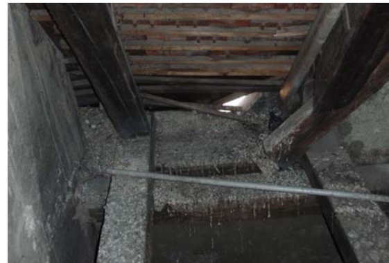
Abb. 4.8: Links: Flickwerk (Palais Herberstein, Graz); Rechts: Schmutz und Taubenkot (Zeughaus, Graz)
