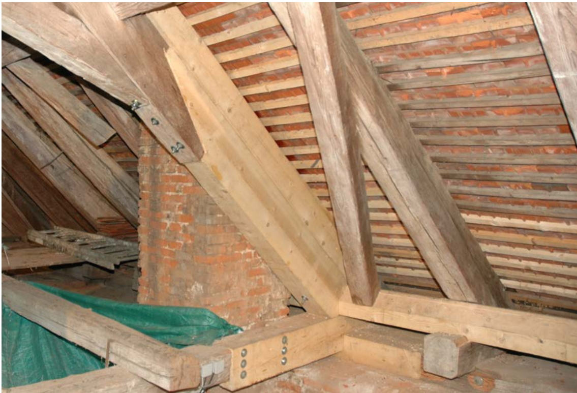
Abb. 5.28: Instandsetzung eines Fußpunktschadens aufgrund Pilzbefall (Alte Universität, Graz)
