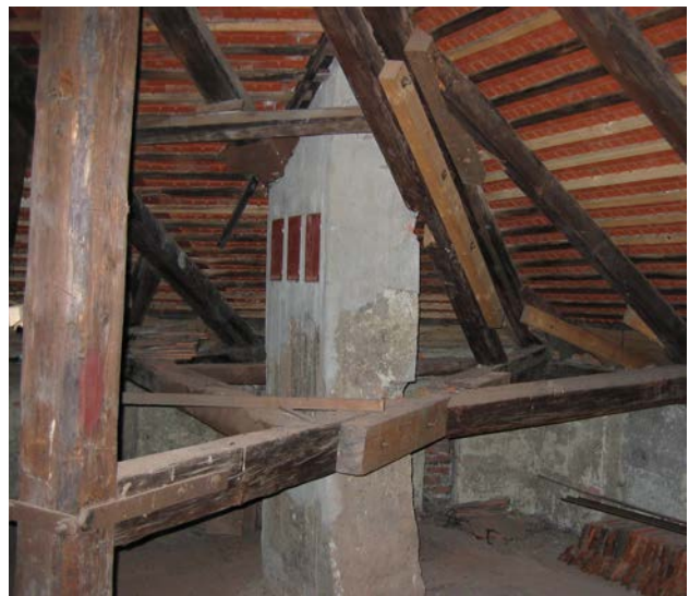
Abb. 4.4: Links: doppeltes Hängewerk als additive Instandsetzungsmaßnahme (Landeszeughaus, Graz); Rechts: Instandsetzung einer Kamindurchführung mittels additiver Bauteile (Lessingstrasse 27, Graz)
