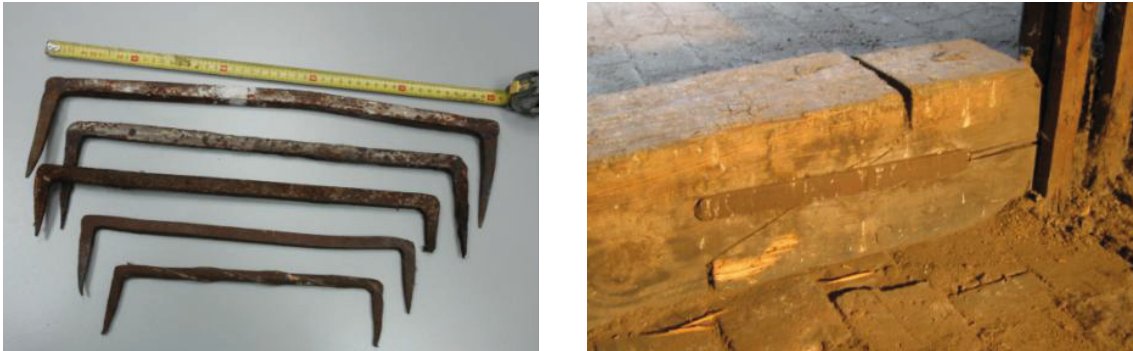
Abb. 2.17: Links: typische Form und Abmessungen von historischen Klammern; Rechts: Anwendungsbeispiel von Klammern bei einem Längsstoß (vgl. MEISEL (2013))
