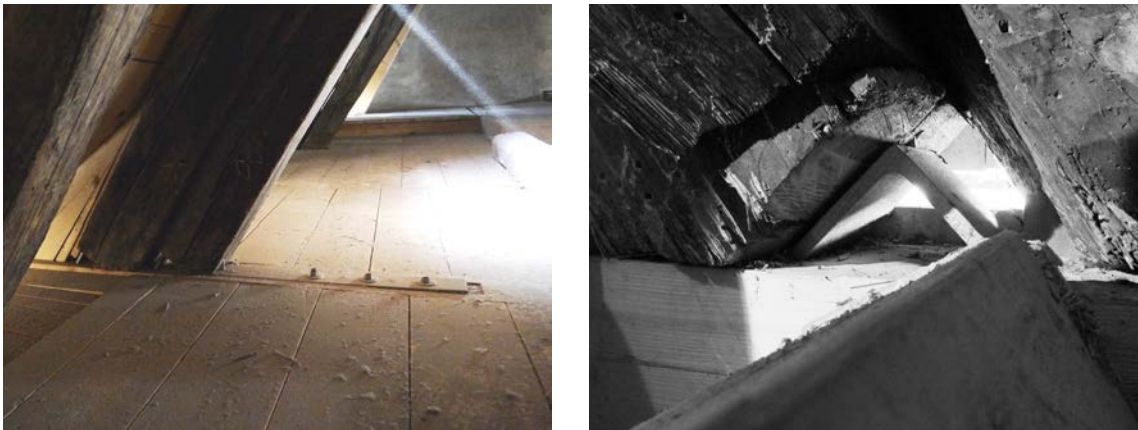
Abb. 5.22: Instandsetzung eines Bundtrah – Sparren bzw. Stuhlsäulenanschlusses mittels Flacheisen und aufgeschweißten Stahlwinkeln (FOTO: ANDREAS MEISEL – Alter Hof, München)
