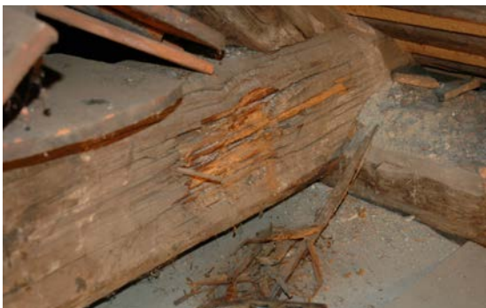
Abb. E.2: Links: Schaden durch Pilzbefall (Graz, Färbergasse 11); Rechts: Vernagelung Fußpunkt (Graz, Sackstrasse 16)
