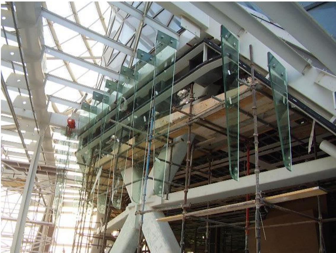
Abbildung 1.2 Glasschwerter im Bauzustand [2]
