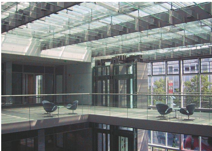
Abbildung 2.4 Dachkonstruktion Atrium Stadtparkasse, Köln [19]
