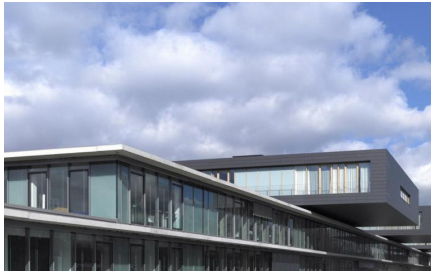
Abb. 87: m3 architectes s.a., Rehazenter Luxemburg, Nordfassade Quelle: www.beton.org/sixcms/media.php/256/thumbnails/rehazentrum_01_536.jpg .97336.jpg (Stand:07.11.2013)
