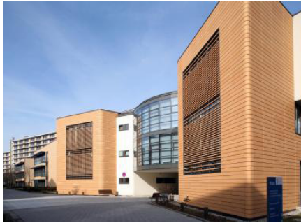
Abb. 72: Stefan Ludes Architekten, Frührehabilitation Allgemeines Krankenhaus St. Georg, Terrakottaverkleidung der Fassade Quelle: www.presseportal.de/bild/103660 (Stand:07.11.2013)
