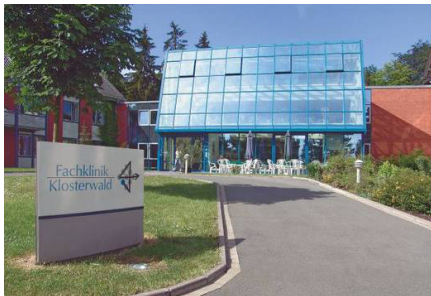
Abb. 58: Verbindungsbau/Eingangshalle Fachklinik Klosterwald Quelle: http://www.fachklinik-klosterwald.de/ (Stand: 07.11.2013)
