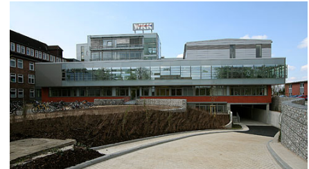
Abb. 81: Planungsring Mumm+Partner, Frühreha und Geriatrie Wüstenklinikum Heide, Einfahrt Tiefgarage Quelle: www.planungsring.de/119/101_10.jpg (Stand: 07.11.2013)
