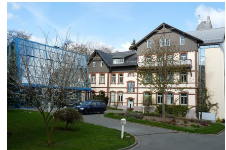
Abb. 60: Verbindungsbau/Eingangshalle Fachklinik Klosterwald Quelle: www.bad-klosterlausnitz.com/cmsupload/1-cms12-506-g.jpg (Stand: 07.11.2013)
