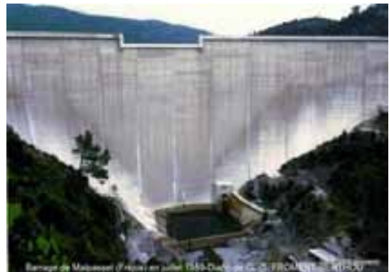
Abbildung 2.2: Malpasset vor dem Unglück, Grundablass und Tosbecken sind gut erkennbar 23
