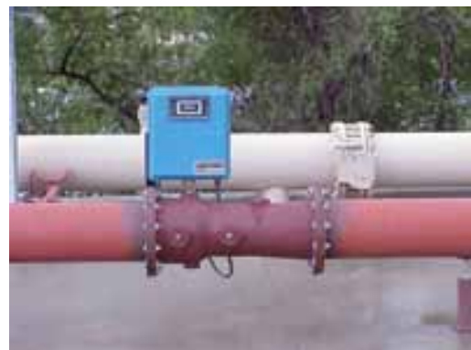
Abbildung 4.64: Durchflussmessung mit Venturi-Kanal, Anwendungsbeispiel 158
