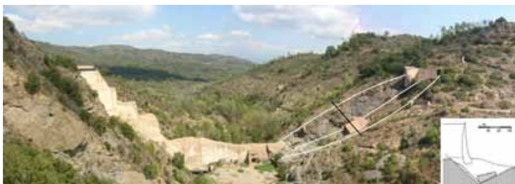
Abbildung 2.3: Überblick der zerstörten Sperre mit Skizze der Untergrundverhältnisse 24
