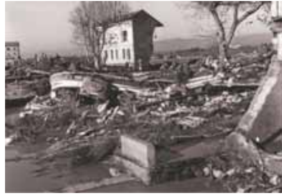
Abbildung 2.5: Durch die Flutwelle zerstörte Häuser in Fréjus 26
