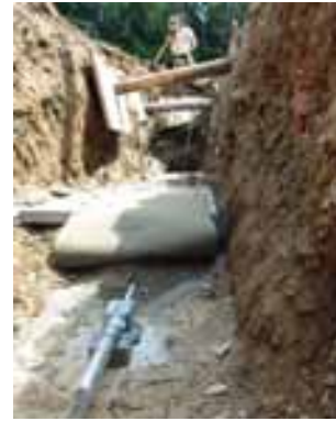
Abbildung 4.31: Verlegung eines Faseroptischen Extensometers im Erdreich 118
