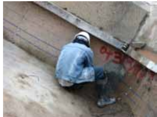
Abbildung 4.78: Leckageortung mittels DTS bei der Sperre Nam Ngum 2 172
