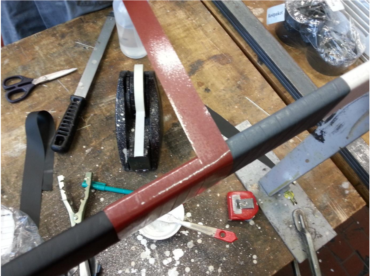
Abbildung 10.3: Manuelles wickeln von AGS, EGS und Wickelkopfschutz
