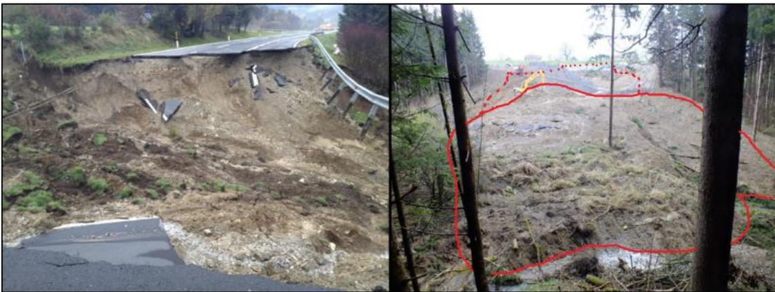
Abbildung 4-11: Anriss und verlagerte Masse der Rutschung Lichtpold (AMLACHER, 14.11.2013)
