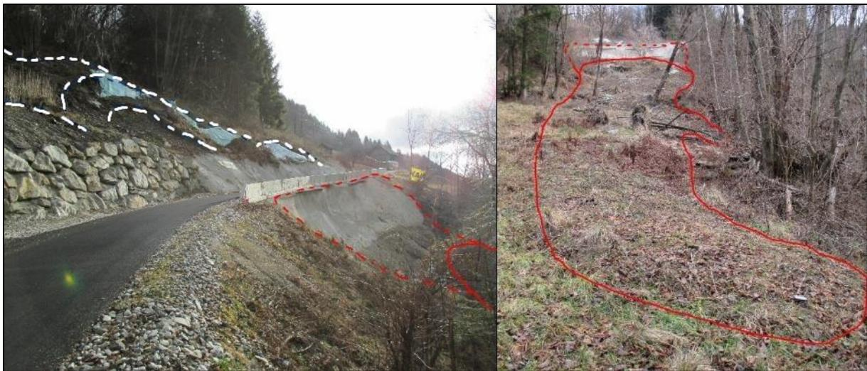
**Abbildung 4-9: Anriss der aktuellen Rutschung mit verlagertem Material (rot) und Abrisskanten (weiß) des größeren Rutschkörpers**
