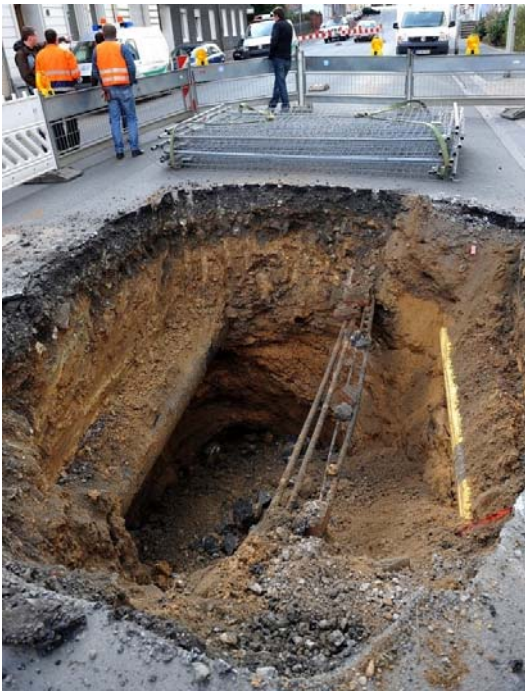
Abbildung 28: Freigelegter Hohlraum in Solingen - Gasstraße (Technische Betriebe Solingen, 2012)
